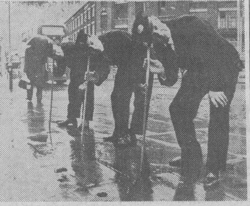
A pesar de las nuevas técnicas aún siguen utilizándose antiquísimos métodos en los más diversos servicios. Vemos en la fotografía a tres técnicos de la Comisión de Aguas de Londres tratando de detectar derrames o filtraciones en las tuberías tendidas bajo el pavimento. Utilizan lo que se llama «palo de sonda», una fuerte vara de fresa con un auricular de madera que haya en un extremo. Ningún dispositivo electrónico ha conseguido sustituir a este sistema tradicional. — (Foto FIEL)
