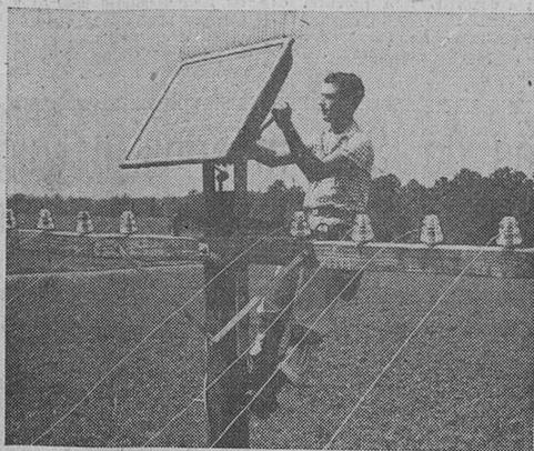
Un celador ajusta en el alto de un poste la batería solar inventada por la Compañía Telefónica Bell para hacer las primeras llamadas utilizando energía generada por el sol. Esta batería proporciona actualmente energía eléctrica para un servicio telefónico rural en el Sur de los Estados Unidos.
