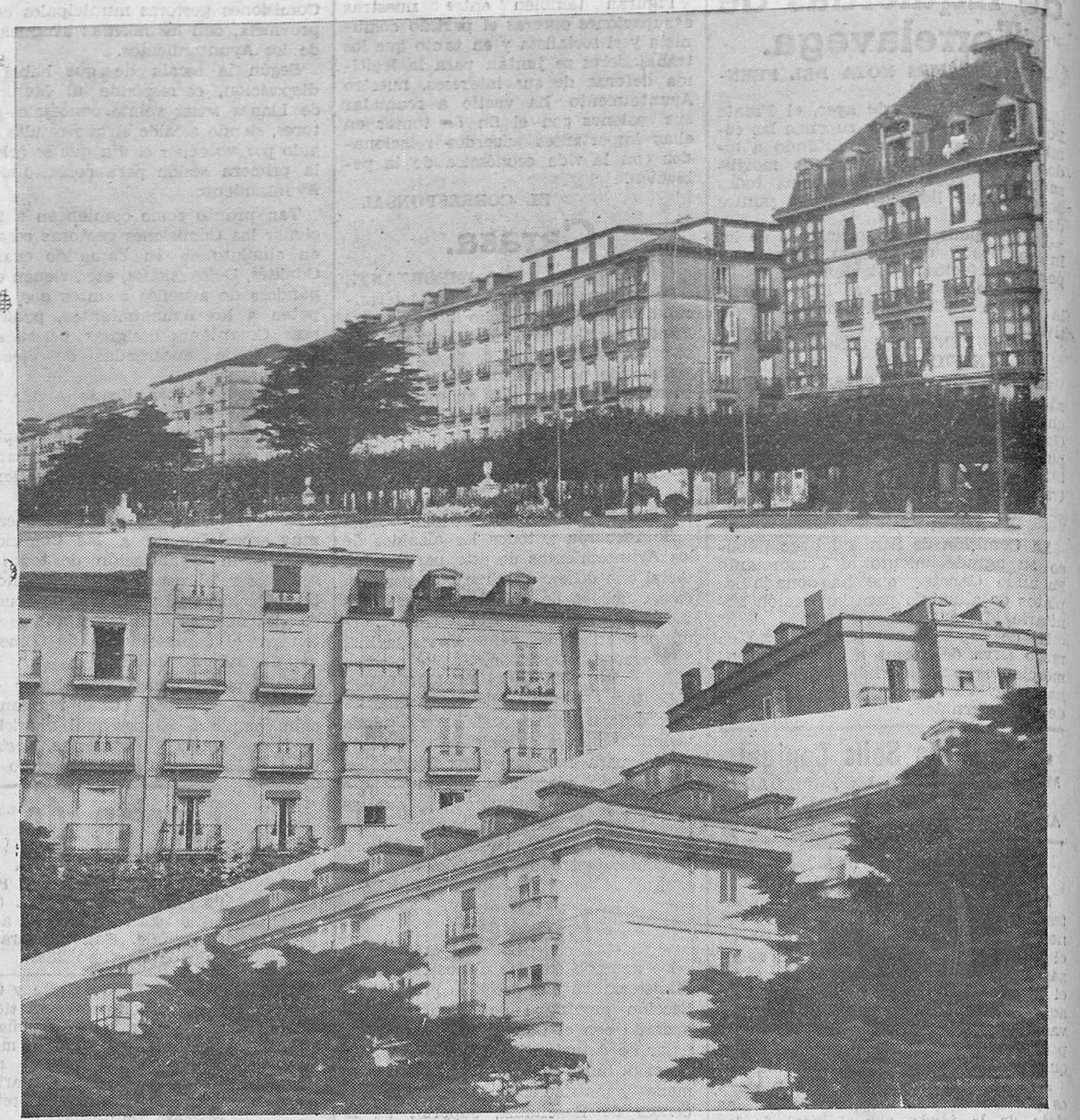
Nuestro fotógrafo «Samot» ofrece hoy al alcalde el lamentable aspecto de algunos tejados del paseo de Pereda—el mejor de Santander—, y en el que se han efectuado reformas y construcciones que desdichan y afean notablemente aquella parte de la ciudad, restándole perspectiva desde la zona marítima.
