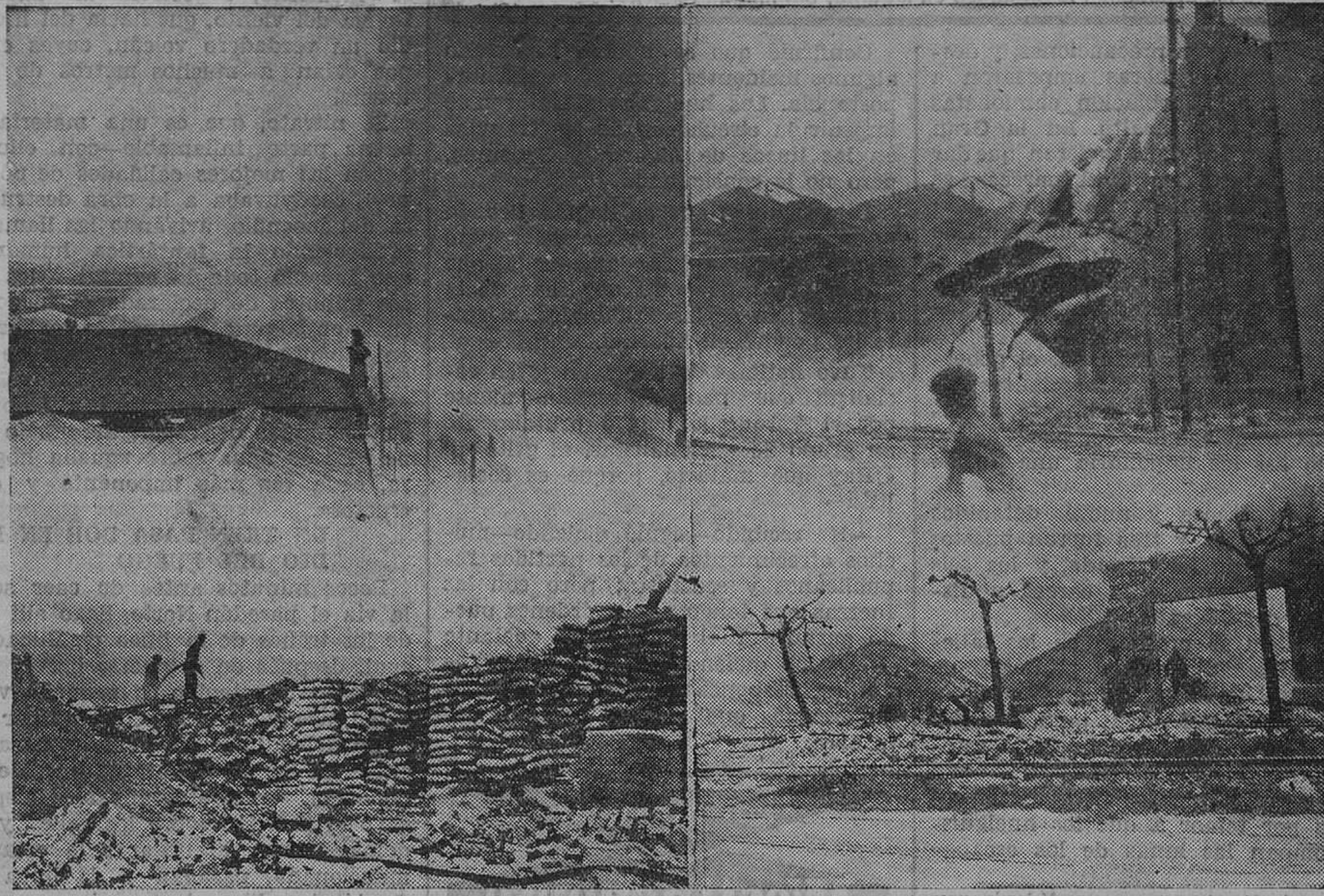
DEL INCENDIO DE AYER. — El fuego, en todo su furor. — Momento de derribar una pared. — Los bomberos, apagando los focos que había entre los sacos. — El escombros, interceptando la vía del ferrocarril de Bilbao. (Fotos Samot.)
