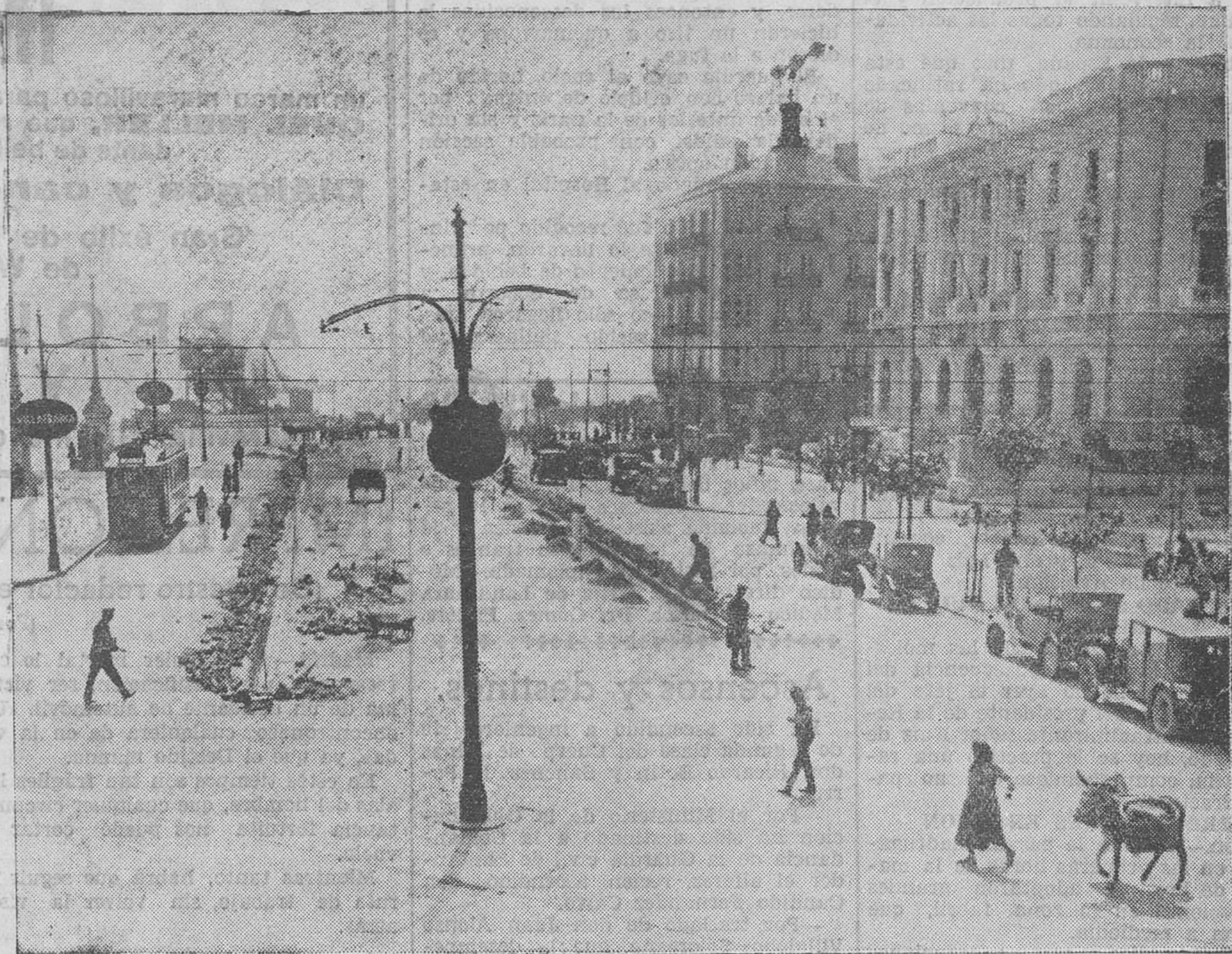
ACIERTOS Y DEFECTOS. — Por cuenta del Municipio se ha ordenado asfaltar la enorme avenida de las farolas, obra que se está llevando a cabo con toda urgencia. Y se nos ocurre preguntar a nosotros: ¿no se podría gestionar de la Compañía de Tranvías que quitase de donde estaban los dos postes sustentadores de sus hilos, uno de los cuales aparece en la foto? Con ello se conseguiría evitar las dificultades que, por culpa de ellos, ofrece la circulación rodada en aquella importante vía. (Foto Samot.)
