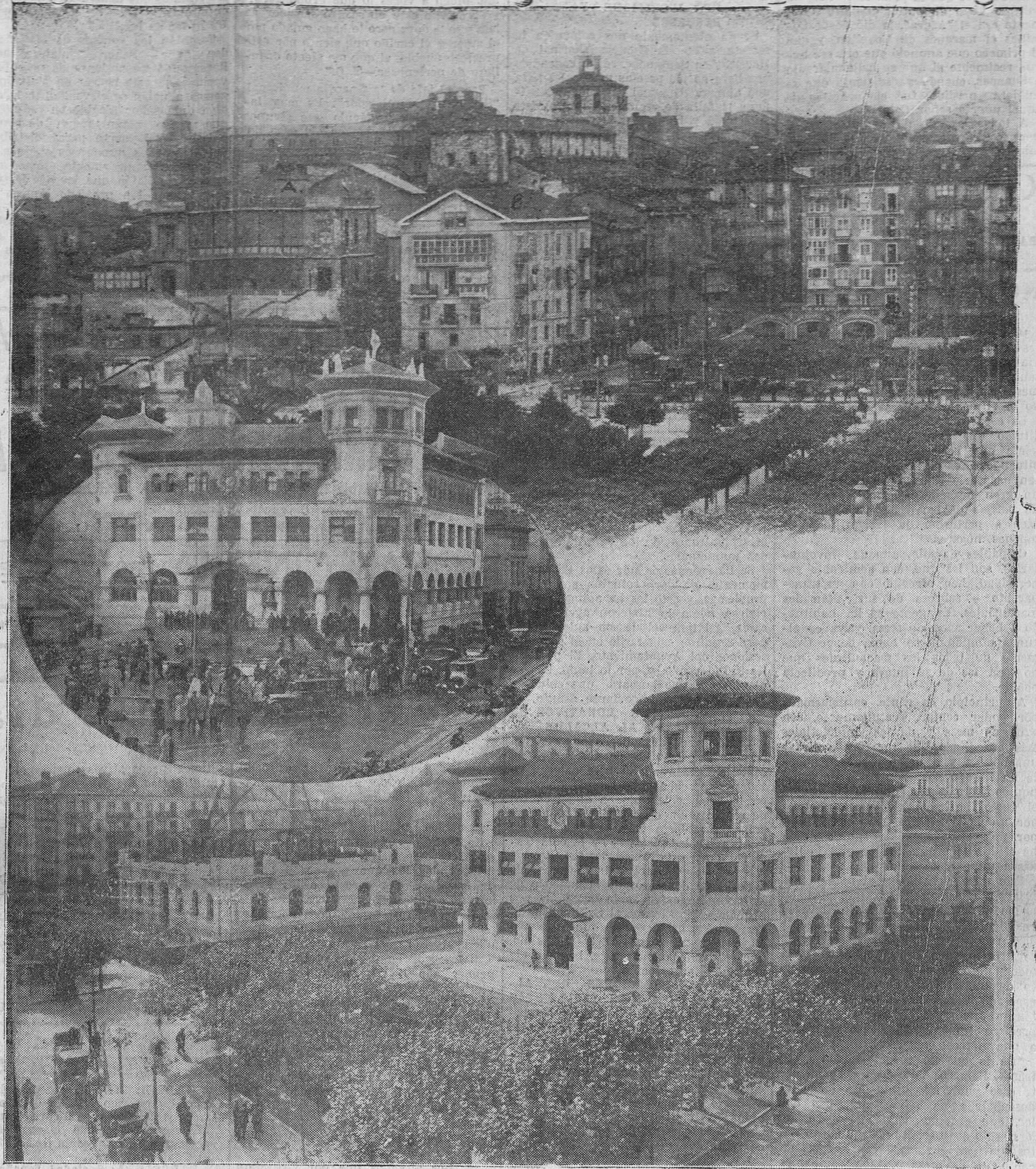
UNA DE LAS VISTAS MÁS ESTRATÉGICAS DEL VIEJO SANTANDER. CUANDO COMENZÓ LA EDIFICACION DEL PALACIO DE CORREOS AUN EXISTIA EL SALON PRADERA (A) Y LAS CASAS B Y C. AQUEL SALON DE ESPECTACULOS Y ESTAS EDIFICACIONES CAYERON DESTRUÍDOS POR LA PIQUETA DEMOLETORA Y SOBRE EL SOLAR QUE DEJARON SE ALZO EL MAGNIFICO EDIFICIO DEL BANCO DE ESPAÑA. EN CAMBIO, EN AQUELLOS TIEMPOS NO EXISTIA EL EDIFICIO G, EN EL QUE HOY ESTAN INSTALADOS LOS JUZGADOS. DICHO EDIFICIO FUE DESTRUÍDO POR UN INCENDIO, Y SOBRE SUS ESCOMBROS, DESPUES DE APASIONADOS DEBATES EN EL MUNICIPIO, SE LEVANTO EL ACTUAL, AOS MAS TARDE SE INAUGURO LA CASA DE CORREOS (FOTO DE LA PARTE BAJA EN LA COMPOSICION), Y POCO TIEMPO DESPUES DESAPARECIO EL ARBOLADO Y QUEDO LA HISTORICA PLAZA COMO ESTA EN LA ACTUALIDAD (FOTO CENTRAL).
