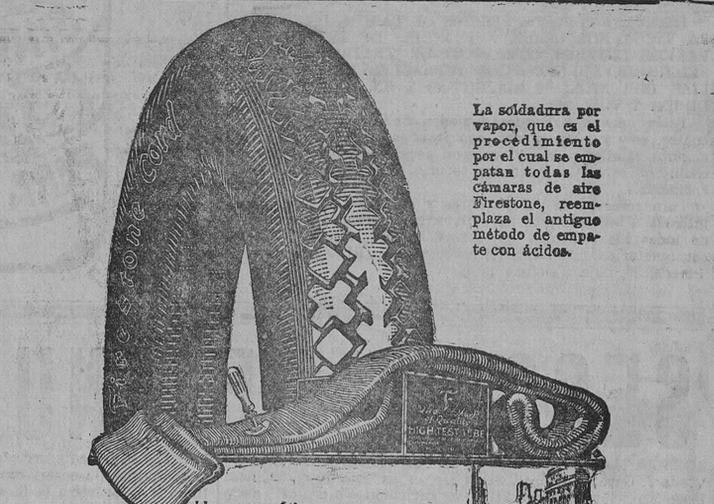
La soldadura por vapor, que es el procedimiento por el cual se empapan todas las cámaras de aire Firestone, reemplaza el antiguo método de empaque con ácidos.
