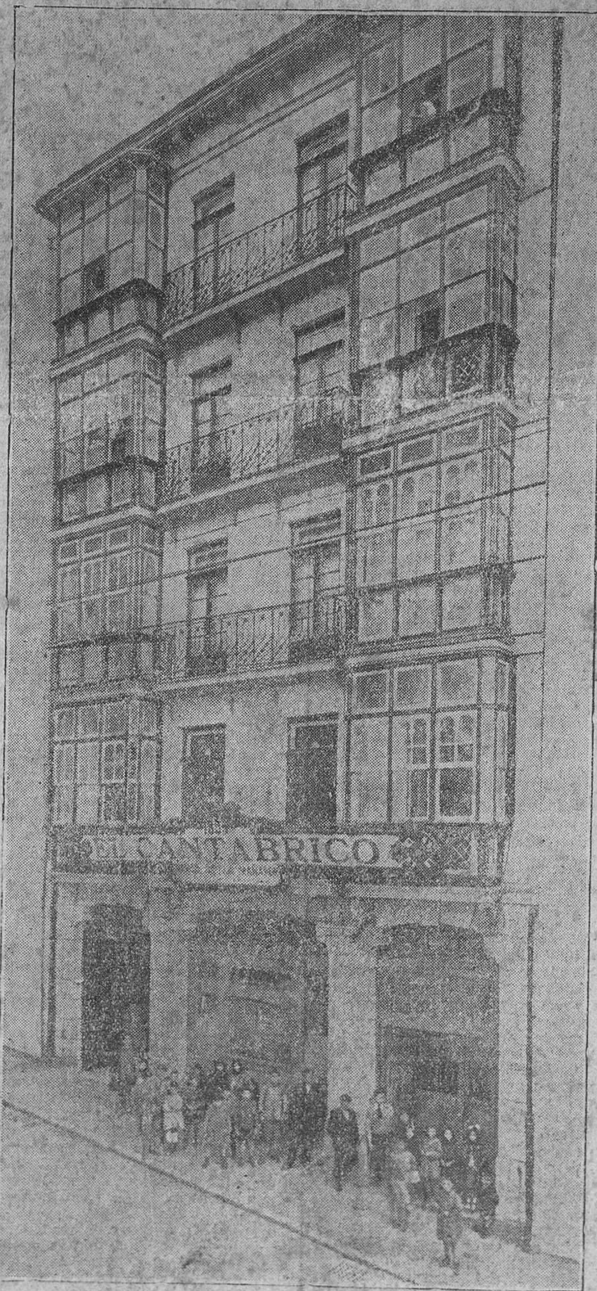
Edificio en que están instaladas las dependencias de EL CANTÁBRICO
