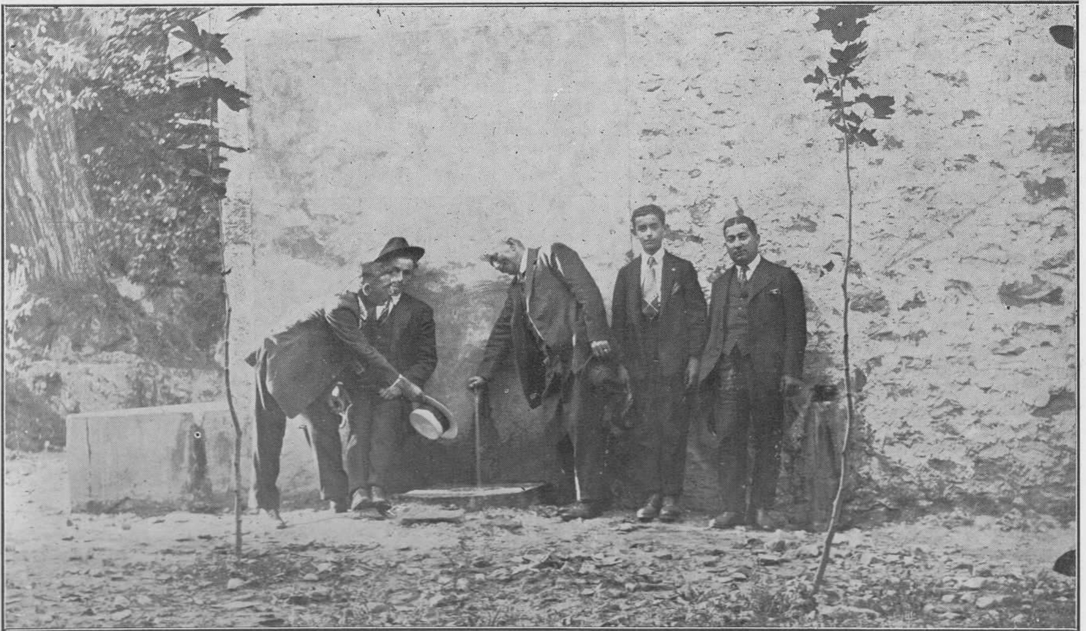
PECHON.—Uno de los hermosos servicios de agua instalados en el pueblo por la "Unión Hijos de Pechón" de la Habana.
