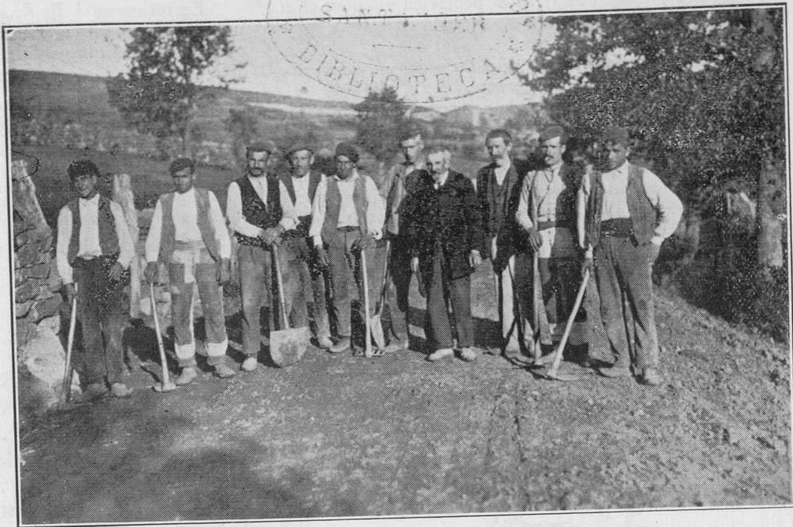
SOBA.—Grupo de trabajadores de la carretera de Aja.
