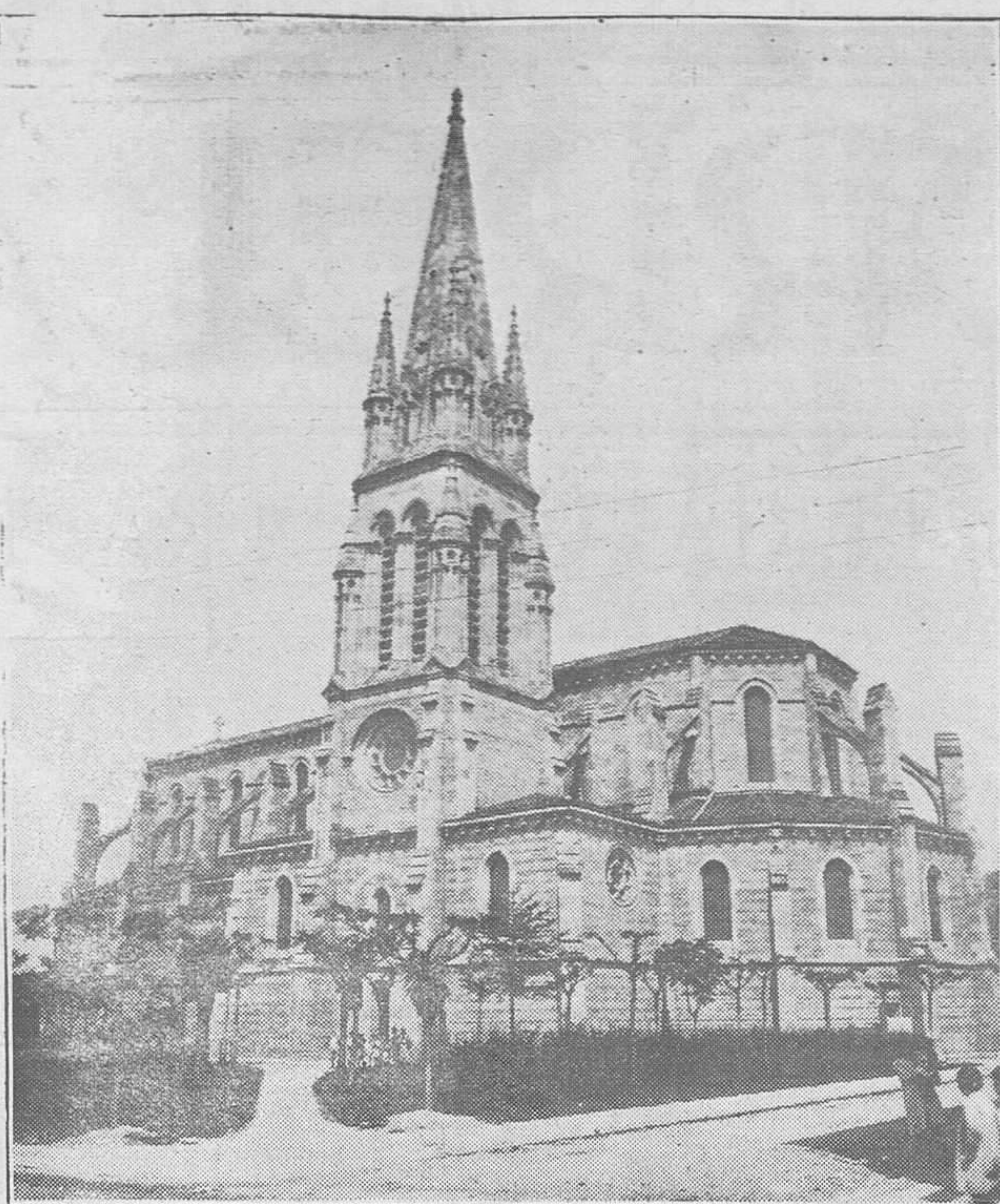
TORRELEVEGA MONUMENTAL.—La preciosa iglesia parroquial, una de las construcciones más notables y bellas de la ciudad.
