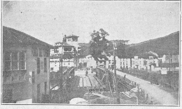
A la derecha el añoso puente que será sustituido en septiembre por el que se ve a la izquierda, cuya moderna construcción de cemento va tocando a su fin. —(Foto Noriega)
