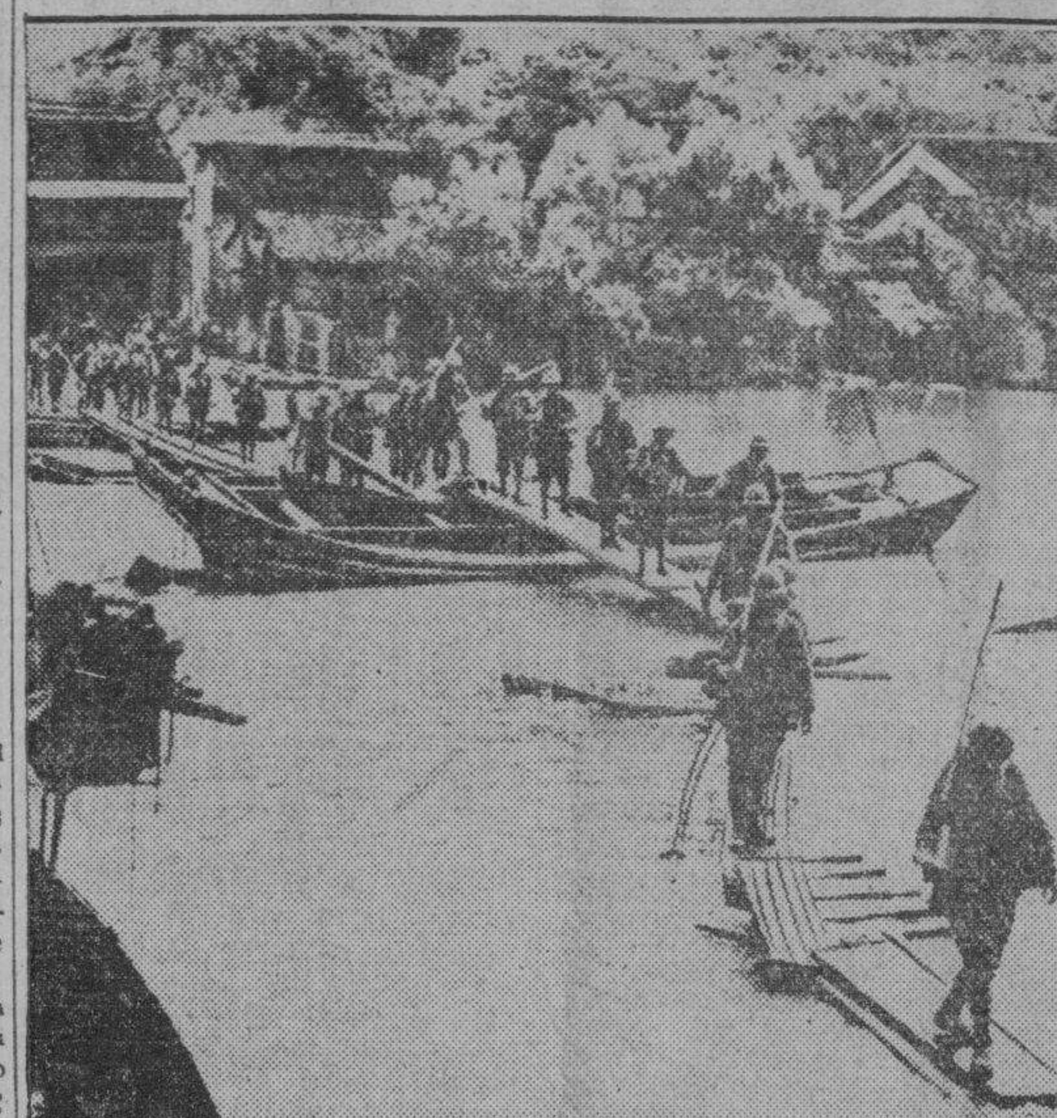
Avanzando hacia Hankow, capital provisional de China, estas tropas japonesas cruzan un puente toscamente construido sobre un riachuelo, que ha crecido subitamente con las aguas desbordadas del río Yangtze. Los japoneses dicen que los diques fueron cortados por los chinos, resultando anegadas extensas áreas.
