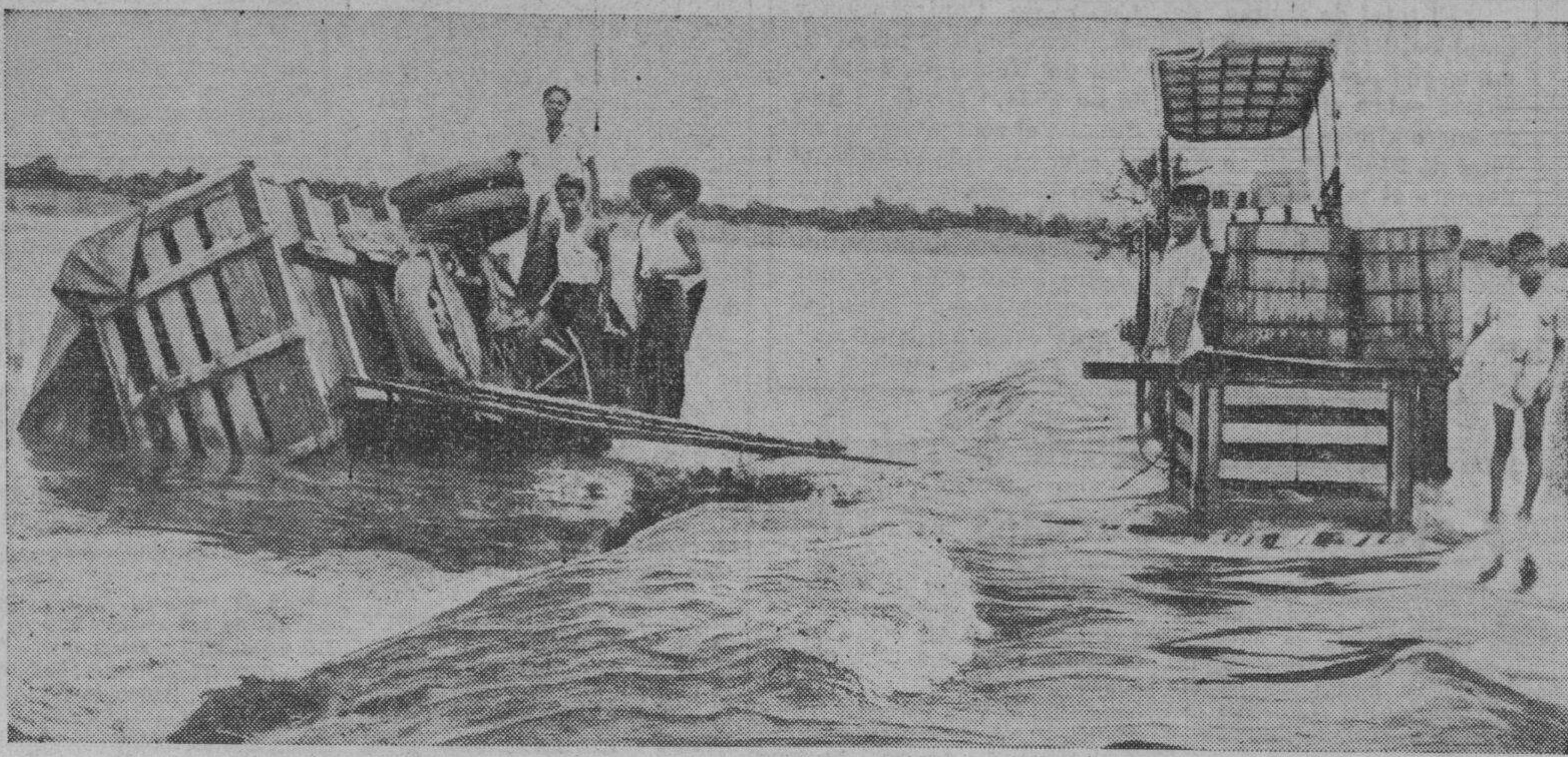
Fotografía tomada del camion T-4136 en la carretera que va a Tarlac cerca del Puente Plaridel. El camion fue barrido por la impetuosa corriente que ya había comenzado a bajar, cuando se hizo la fotografía...
