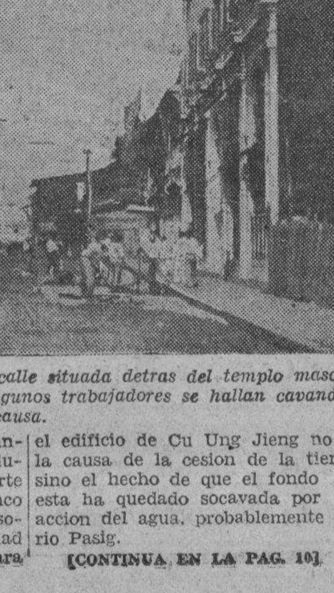
La fotografía demuestra la calle situada detras del templo masonico que se esta hundiendo. Algunos trabajadores se hallan cavando la tierra a fin de averiguar la causa.
