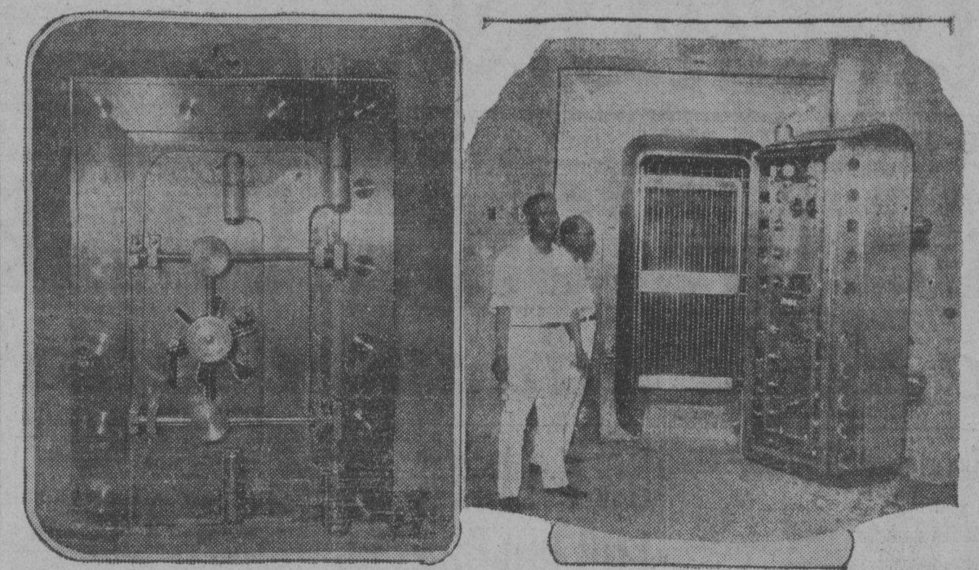
La nueva caja de seguridad en la tesorería insular está construida para retar al más astuto de los ladrones en el mundo. A la izquierda se ve la puerta sólida de la caja tal como aparece estando cerrada, con sus candados y cuadrantes. A la derecha, una vista de la caja estando abierta, demostrando la puerta de acero sólido de 11 pulgadas de grosor con su complicado sistema de llaves. Al lado de la puerta se ven a Adriano Rodenas (de cara al lector), cajero auxiliar de la tesorería y al Sr. Miguel Avellino (mirando a la puerta) cajero y jefe de la casa moneda.
