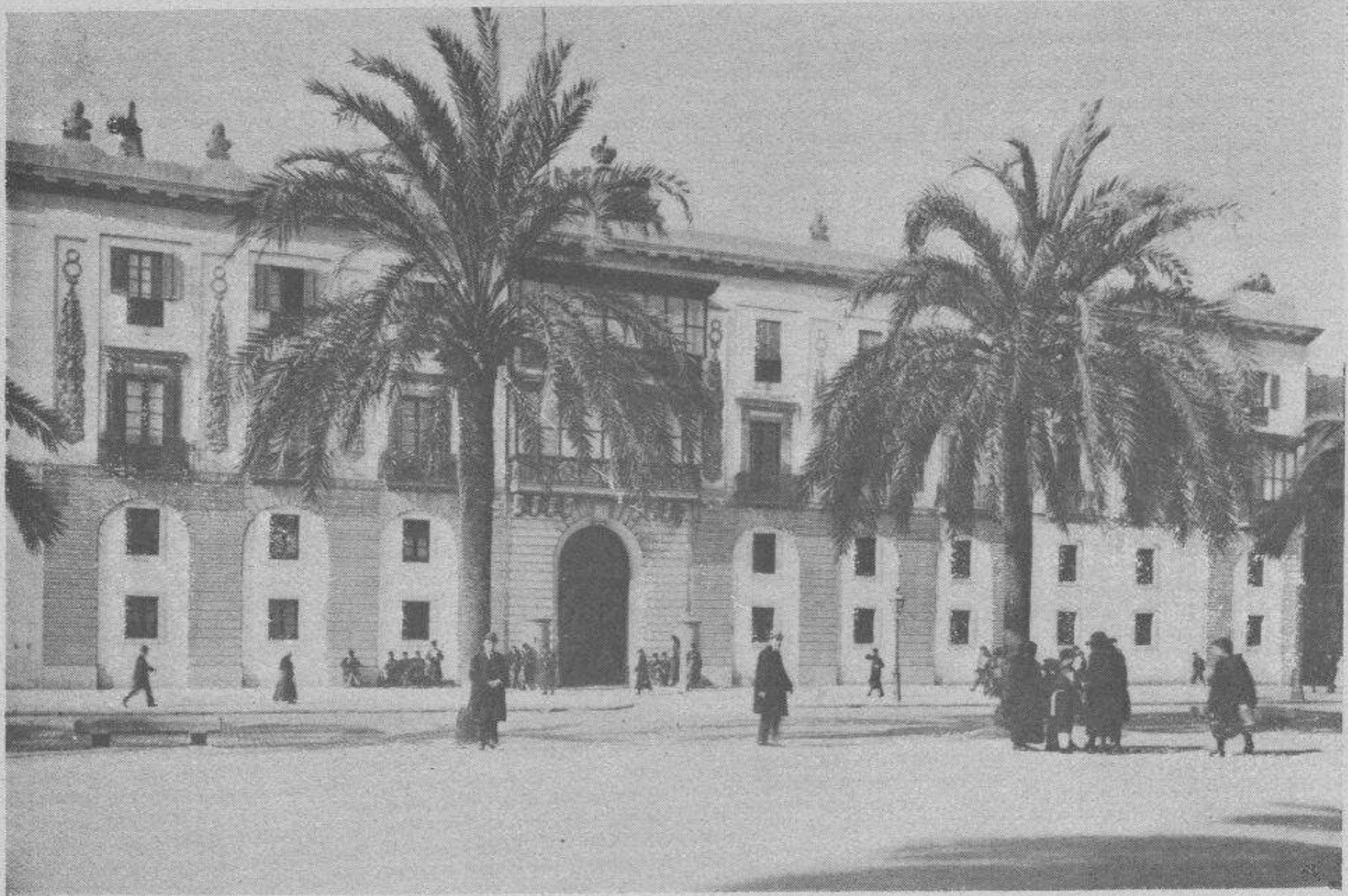
Fachada de la Capitanía, antes de las últimas reformas
