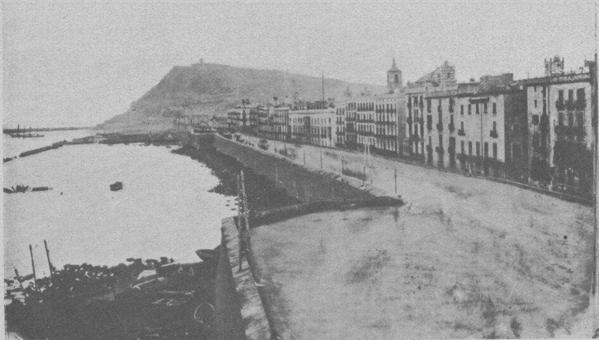
La antigua muralla de mar, frente al edificio de la Capitanía
