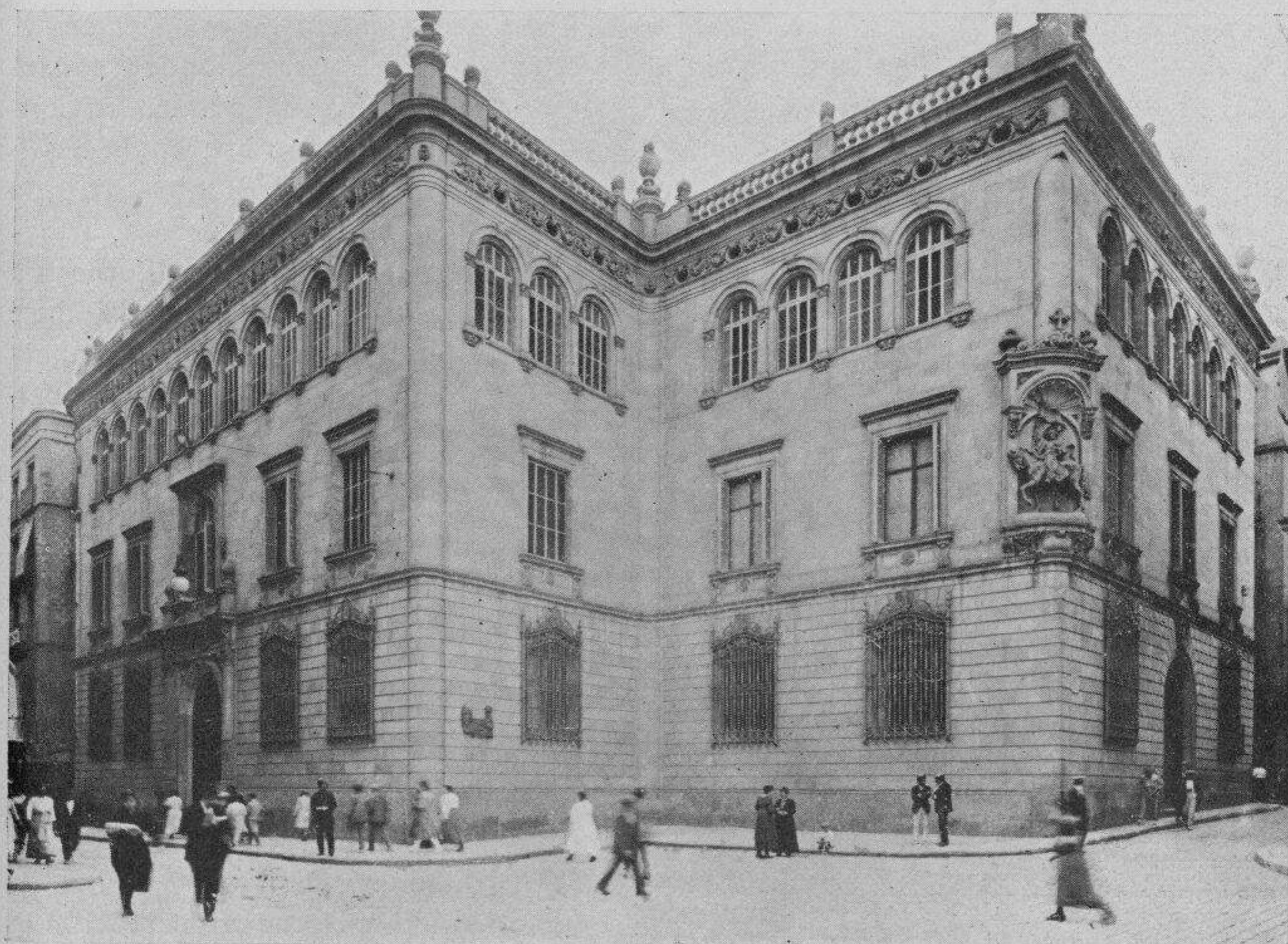
Caja de Ahorros y Montepío Barcelonés. — Caisse d'Épargne et Mont de pitié. Barcelone.
