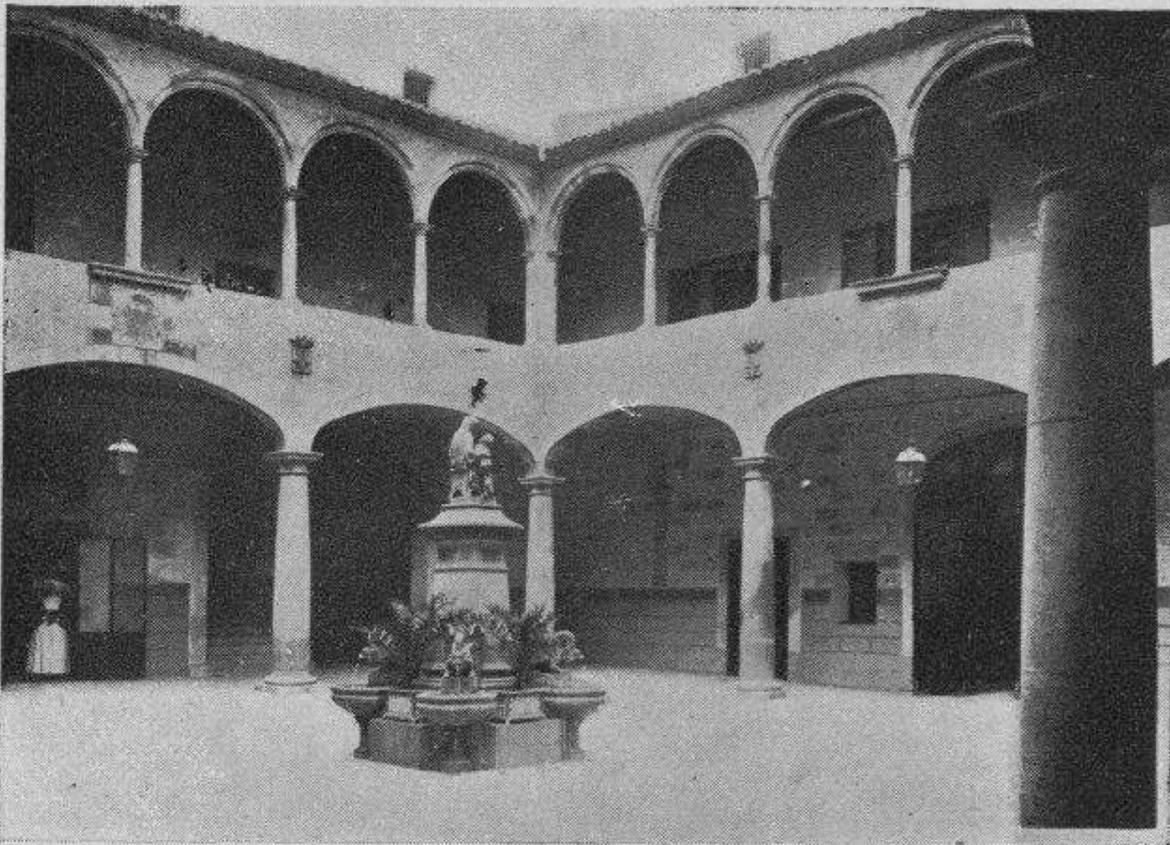
Casa Provincial de Caridad. Patio.
