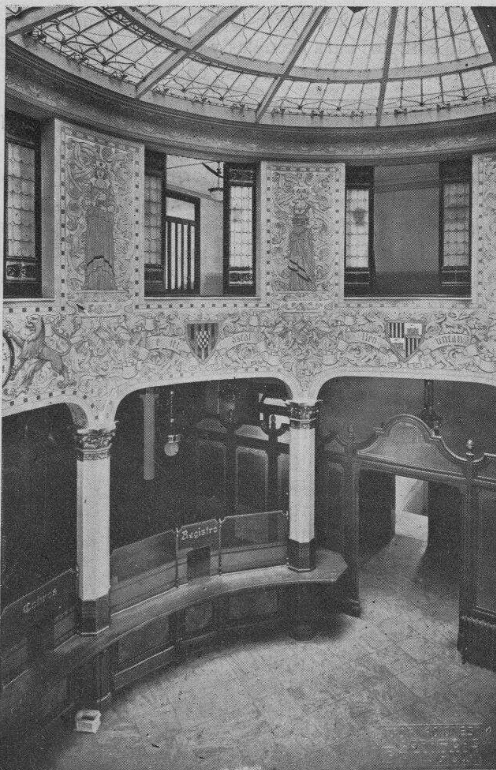
Caja de Ahorros y Pensiones para la Vejez. Vestíbulo. Caisse d'Épargne et des Pensions pour la vieillesse. Vestibule.
