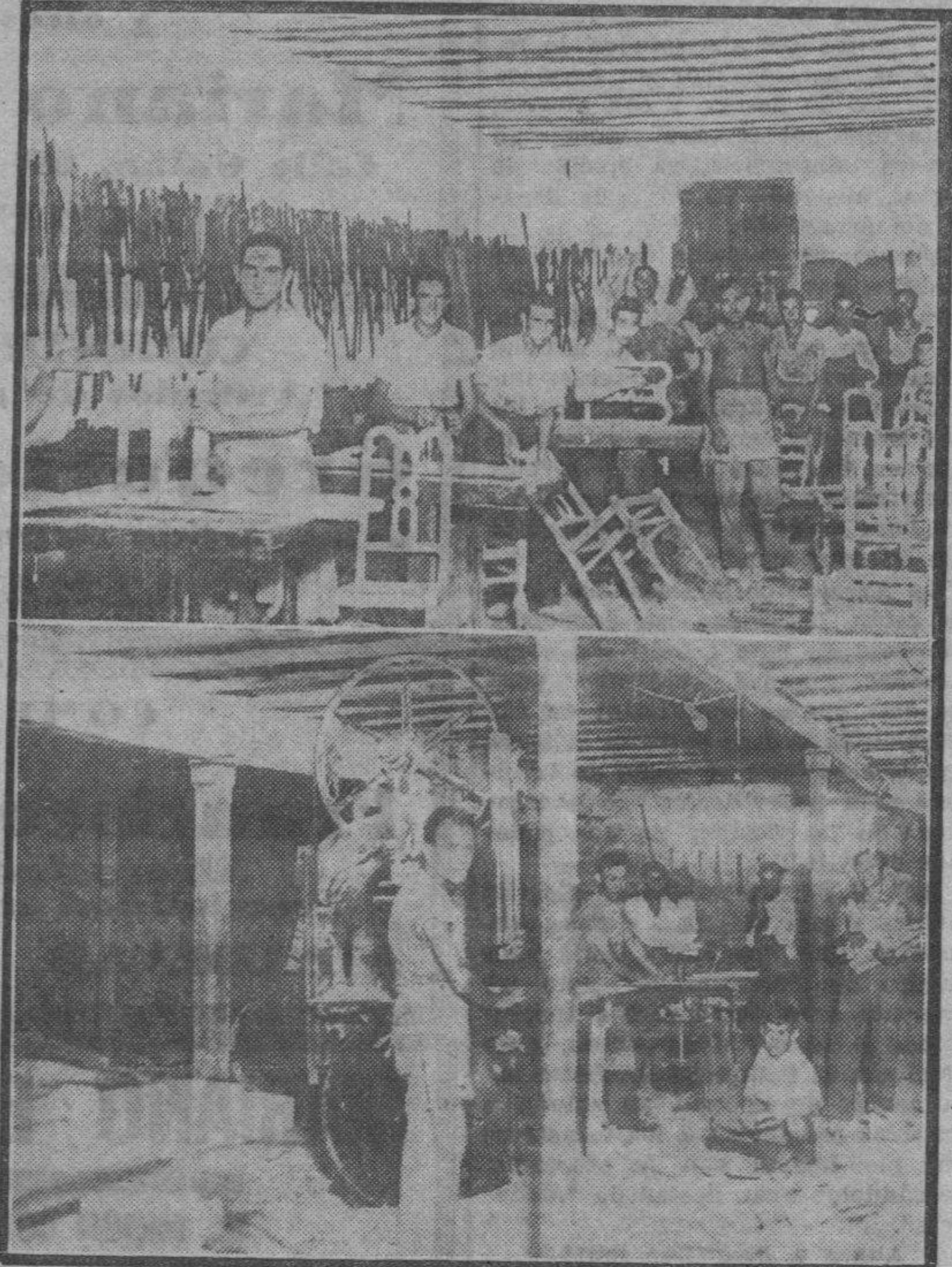
Arriba: Un aspecto del taller de construcción de la importante fábrica de sillas de don Martín Lamana. Abajo: Un detalle de la nave de maquinaria de dicha industria.
