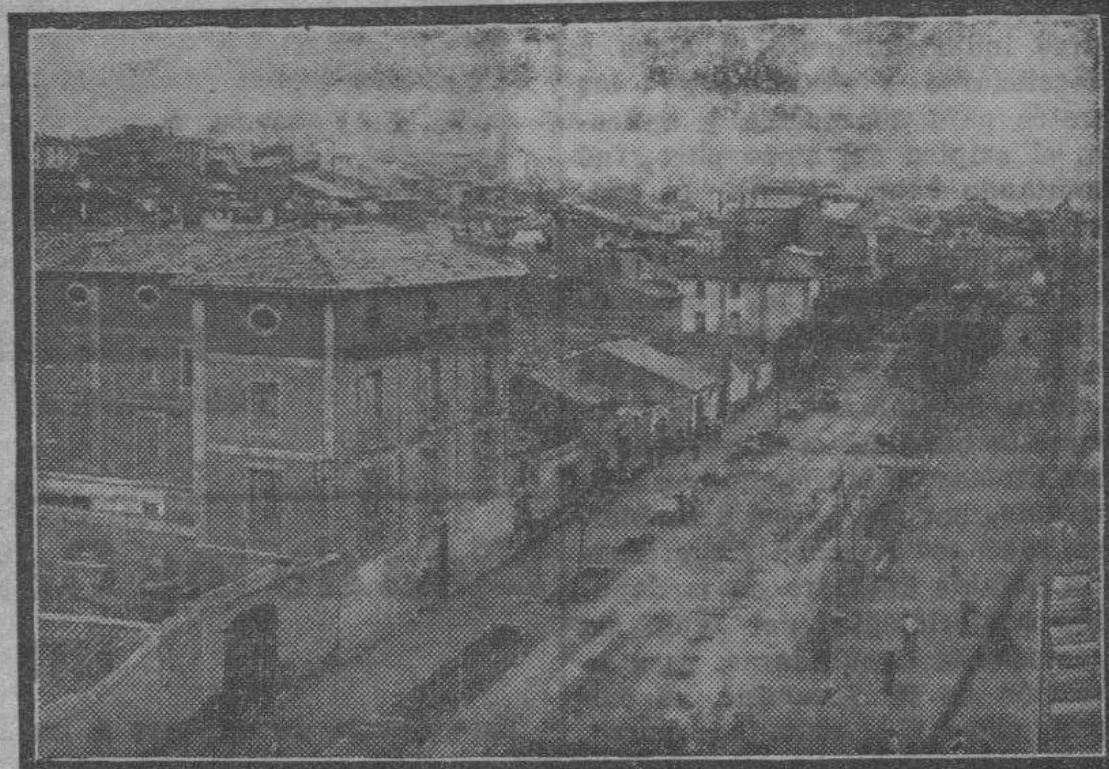
Vista parcial y Avenida de la República; al fondo la torre de Santa María. (Foto. Cepero)
