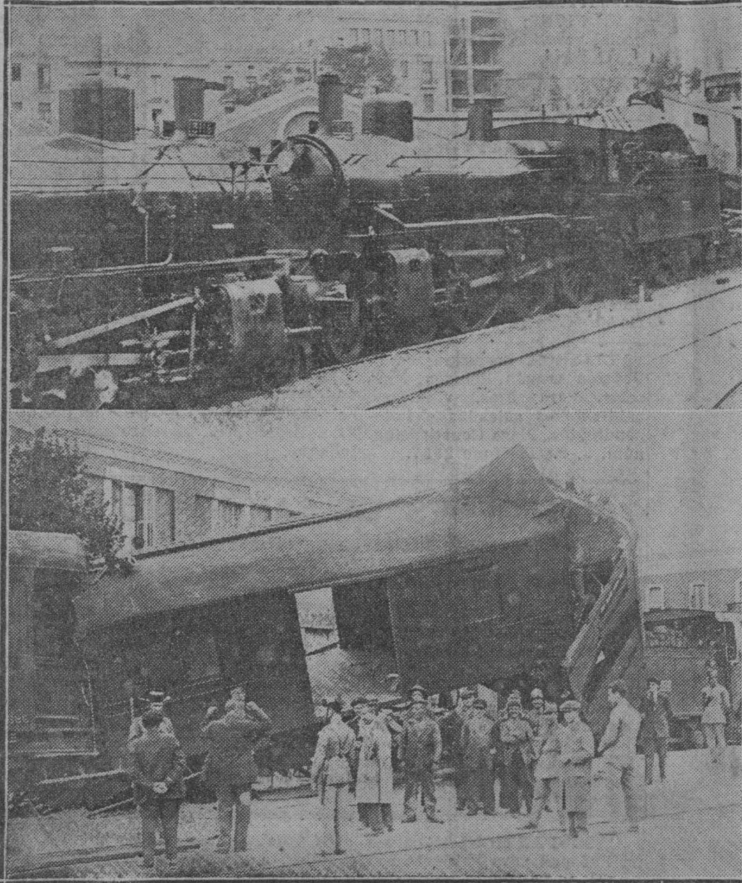
Arriba: Las locomotoras, empotradas.—Abajo: Estado en que quedó uno de los vagones (Foto. A. de la Barrera)
