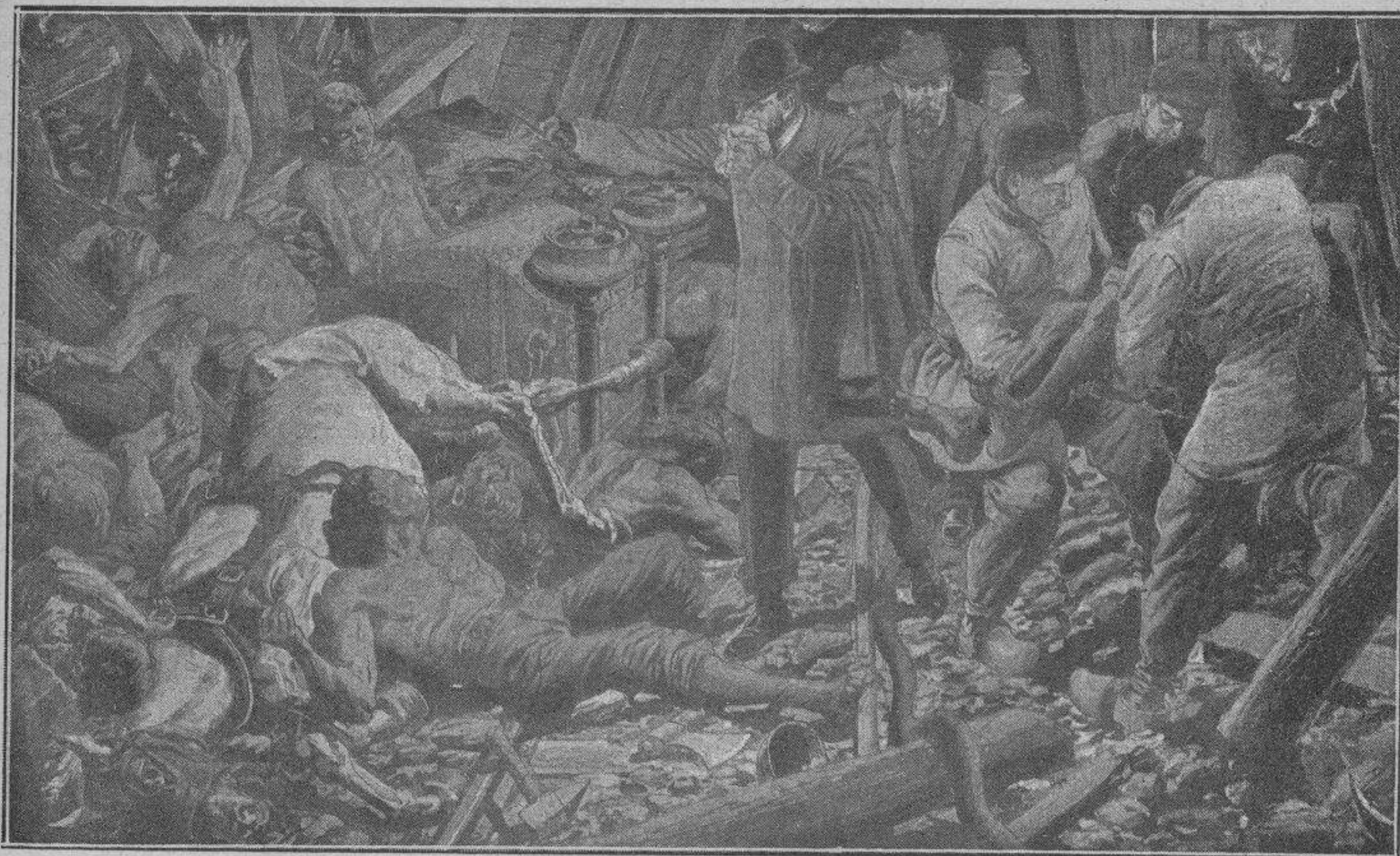
La Catástrofe de Courrières.— Trabajos de salvamento en el interior de la mina.
