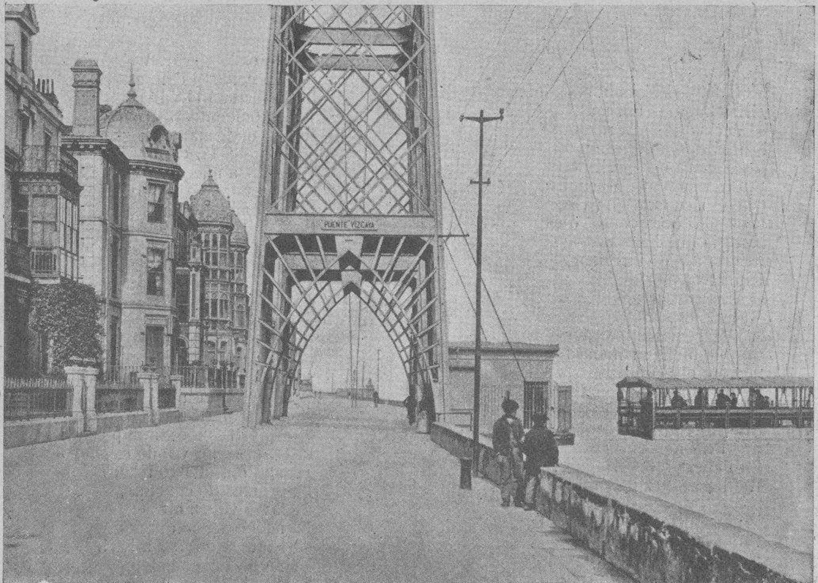
Detalle del Puente Vizcaya (Portugaleta.)
