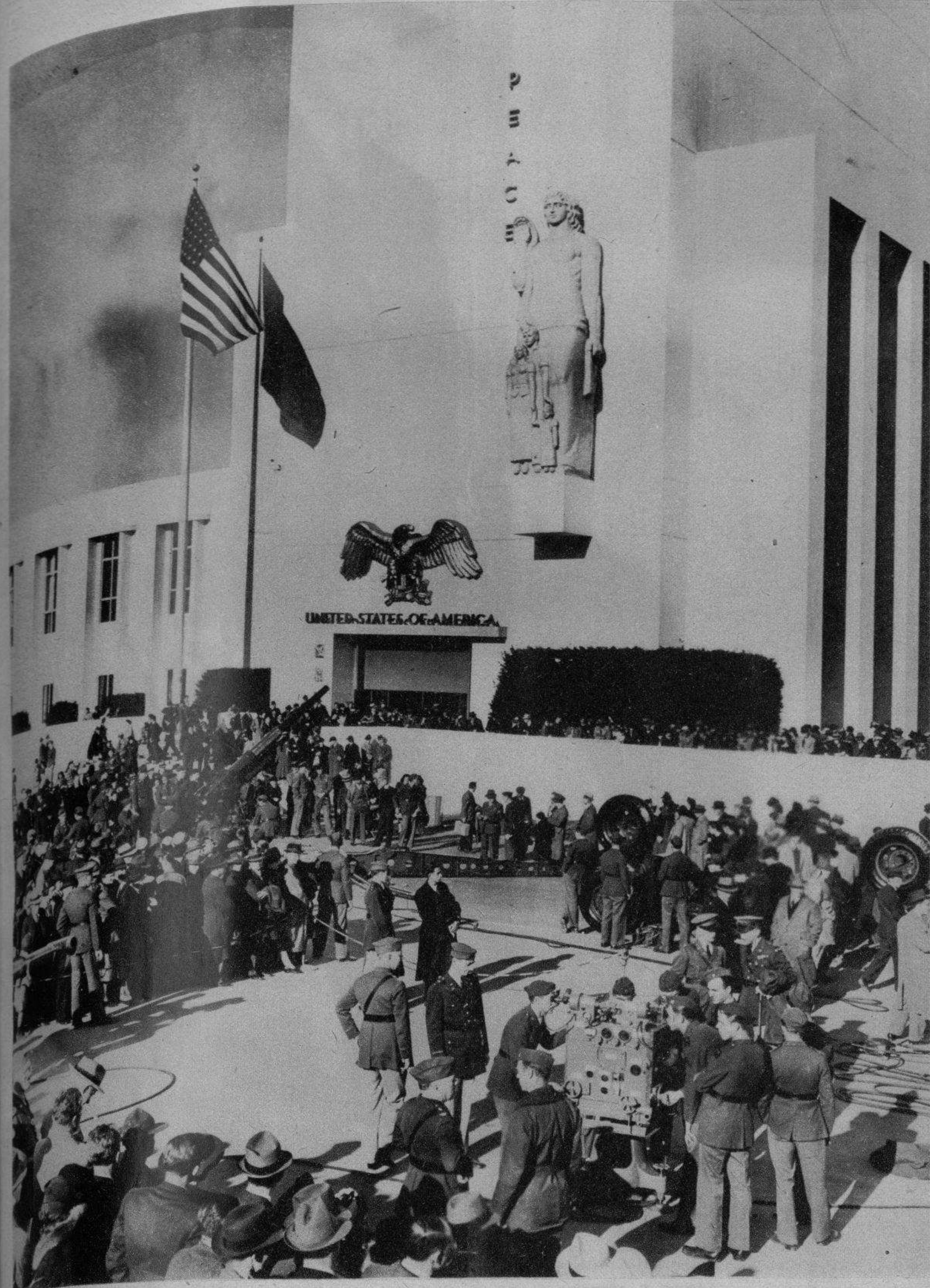
ARTILLERIA de costa en la Feria Mundial de New York.—Los visitantes de la Feria presenciaron la exhibición de un equipo de las unidades del 212 grupo de artillería anti-aérea de costa. La instalación se hizo en la Rotonda de la Paz. Este es un detalle del acto. (Foto Wide)
