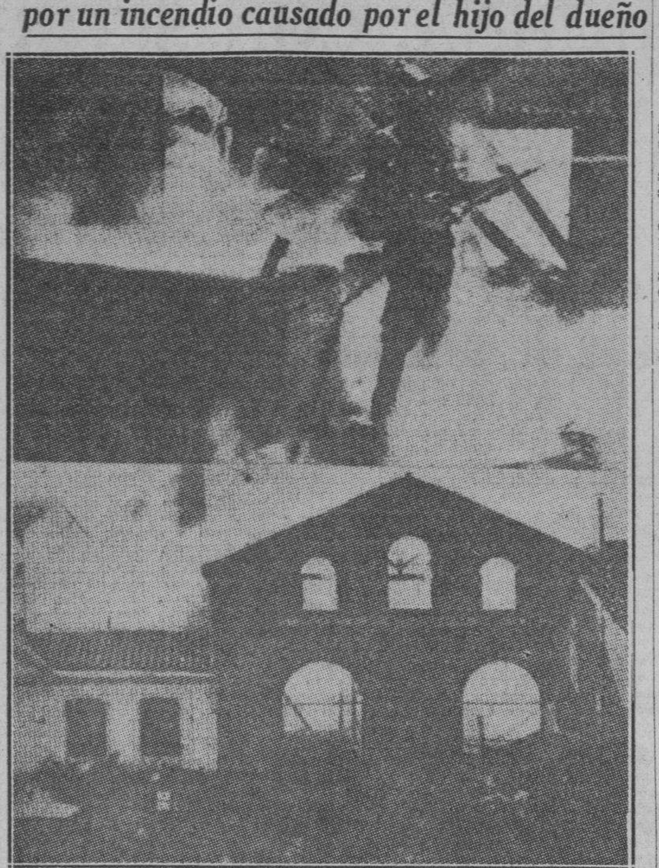
Dos aspectos del siniestro ocurrido en el paseo de Santa María de la Cabeza, en la fábrica de la Unión Vidriera, que ocasionó la destrucción total del edificio.
