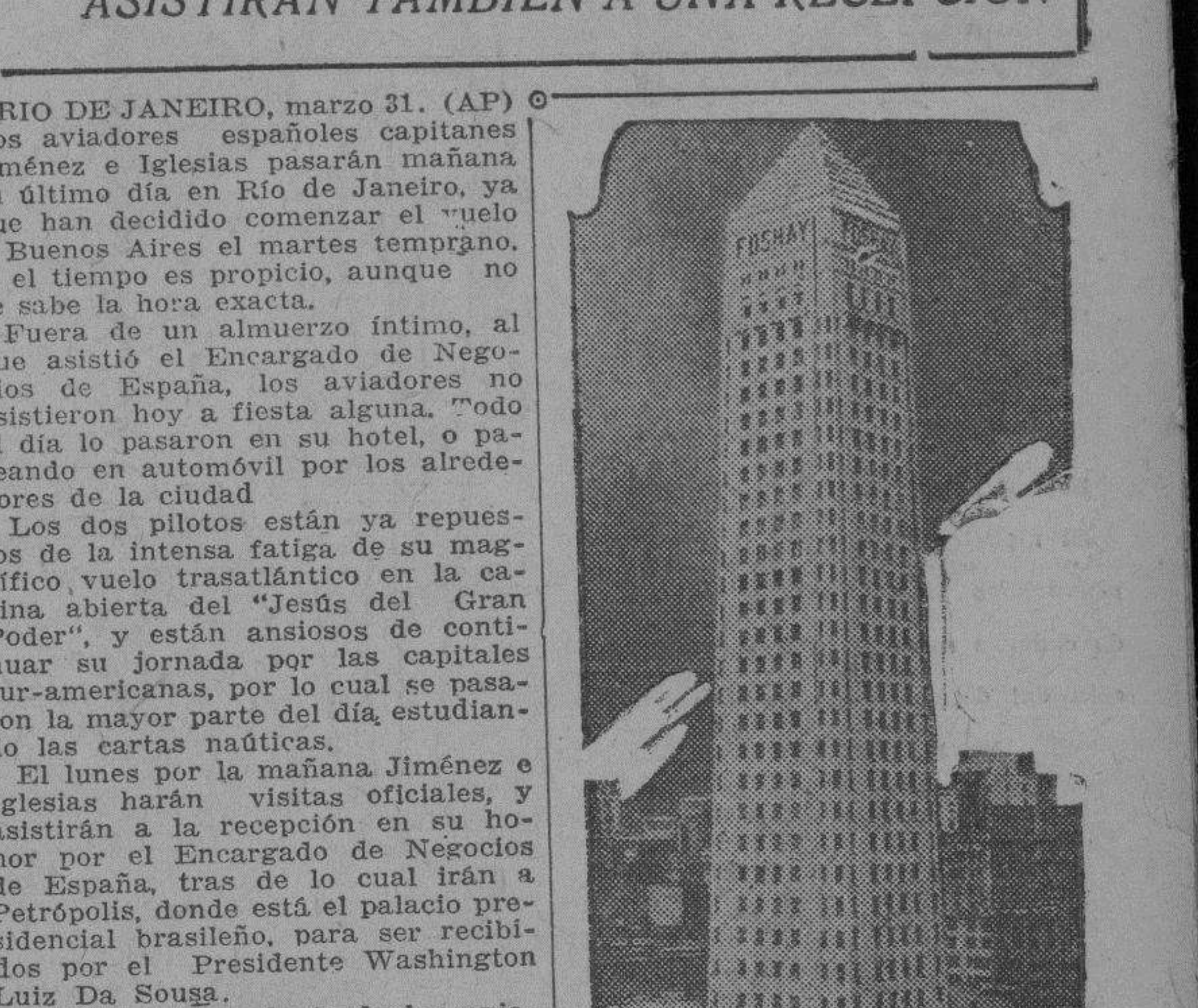
MINNEAPOLIS: marzo. Tan original como el arquitecto que construyó esta torre en la ciudad de Minneapolis, que ha solicitado, para protegerla, una patente. La torre tiene 32 pisos y puede resistir un viento que sopla a razón de 400 millas por hora
