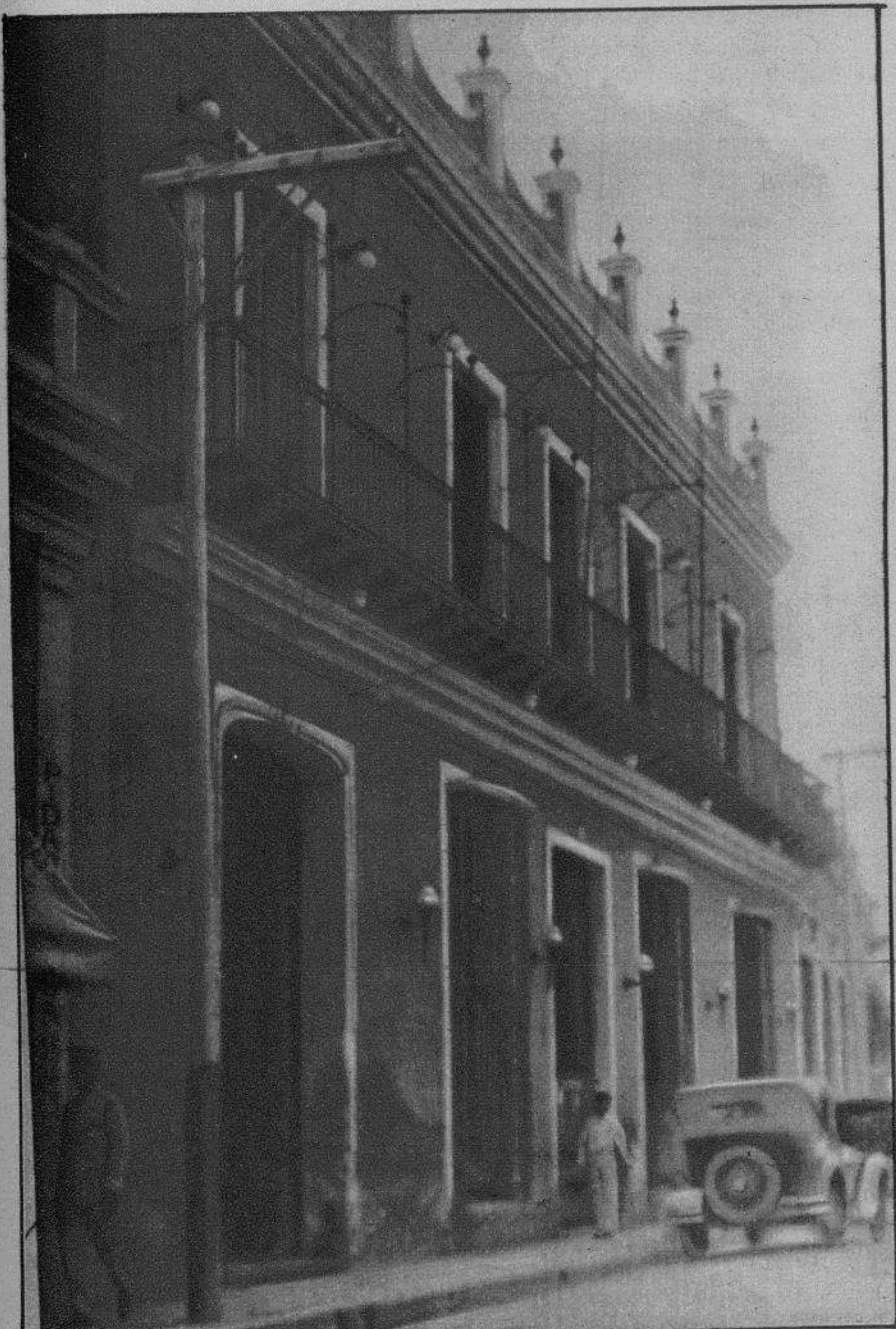
Fachada del edificio social de la Colonia Española de Camagüey.
