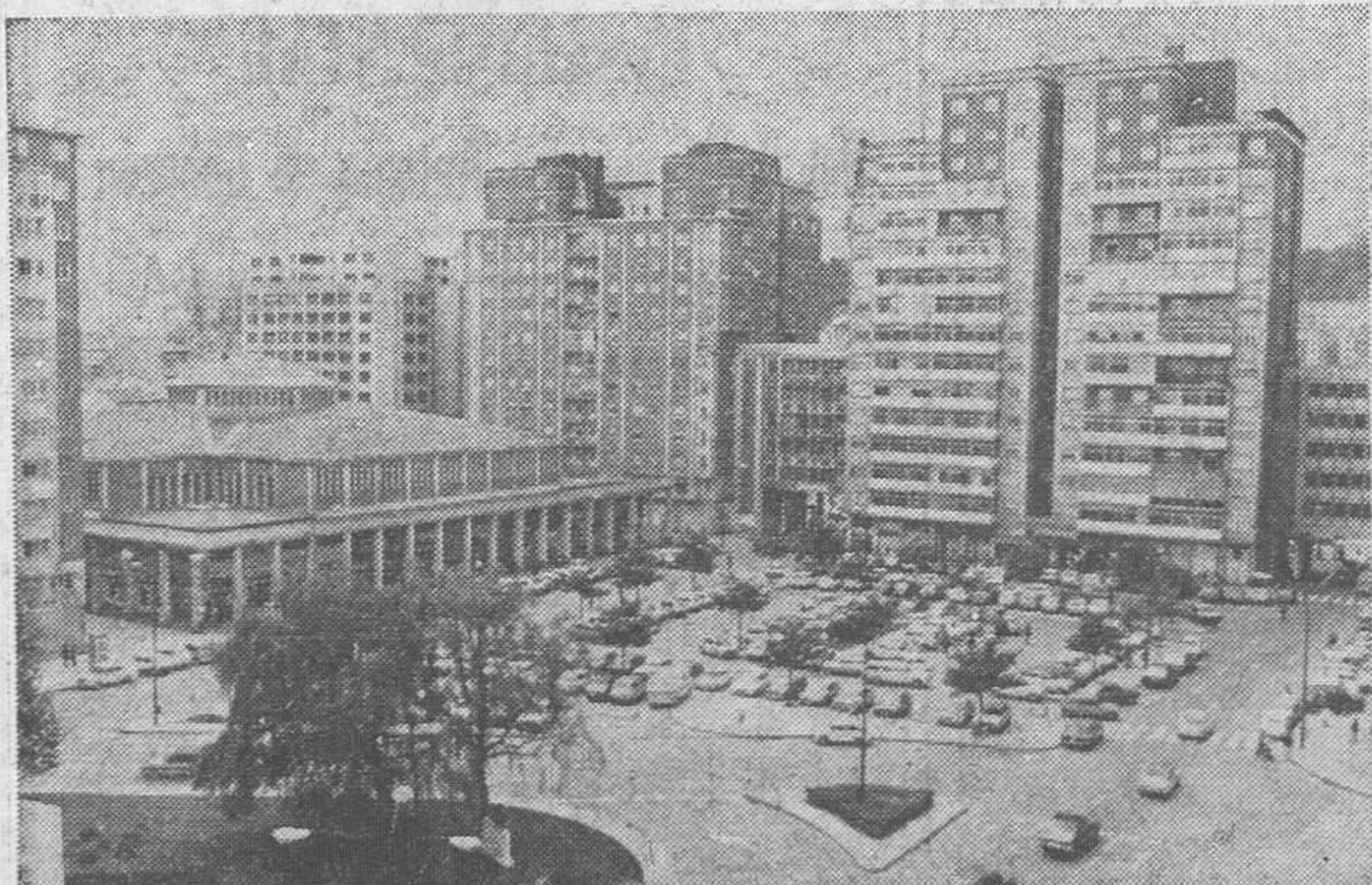
El Ayuntamiento a través de la Sociedad Municipal de Aparcamientos proyecta construir un aparcamiento subterráneo en la Plaza de España. El estudio técnico y las bases técnicas para la adjudicación se está preparando. Ello supondrá levantar todo este recinto urbano. — (Foto VILAFRANCA).
