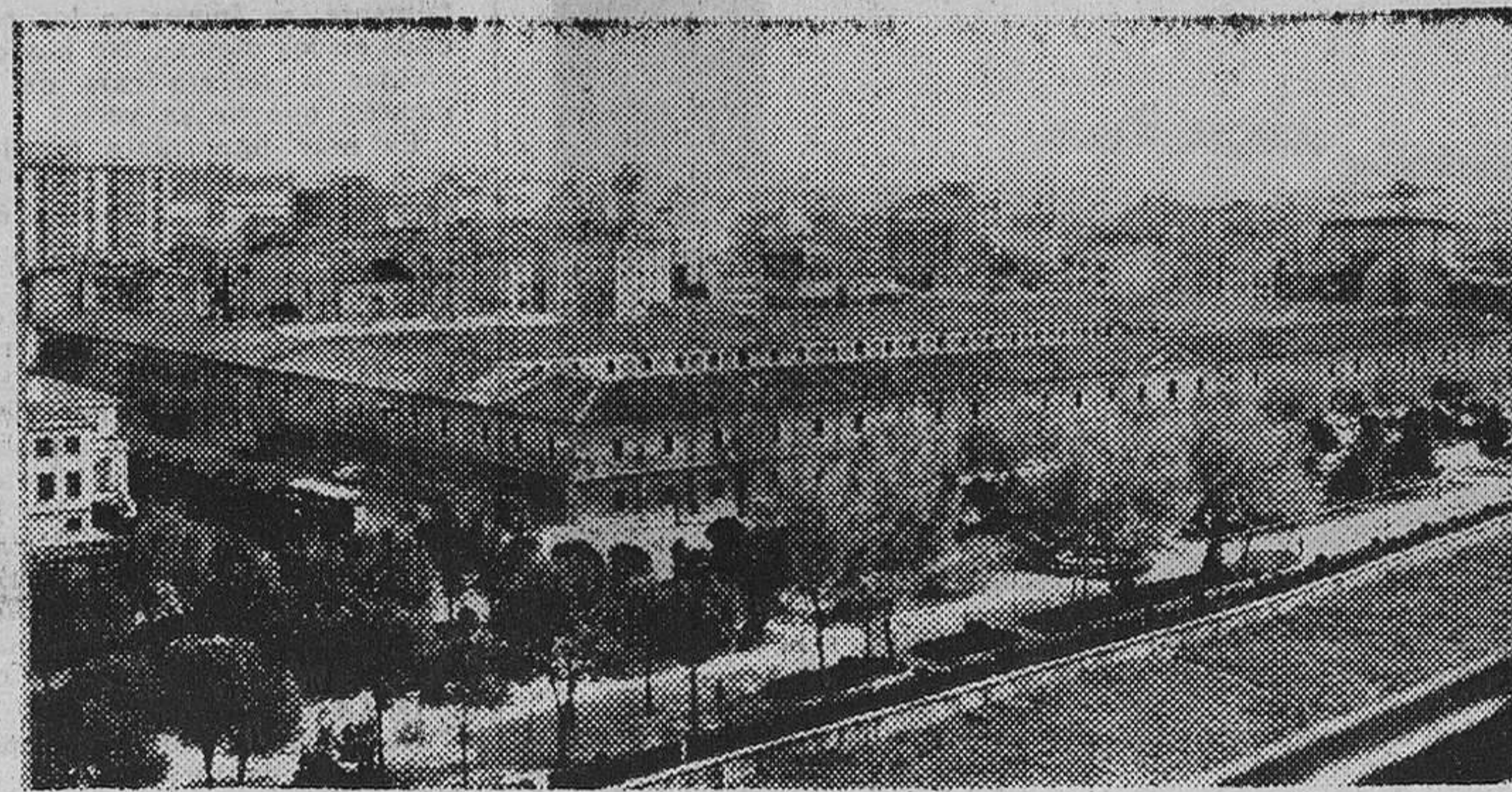
A vista de pájaro, esta es la extensa superficie que ocupa el actual cuartel de Caballería cuya demolición se iniciará en fecha inmediata. — (Foto FEDE).
