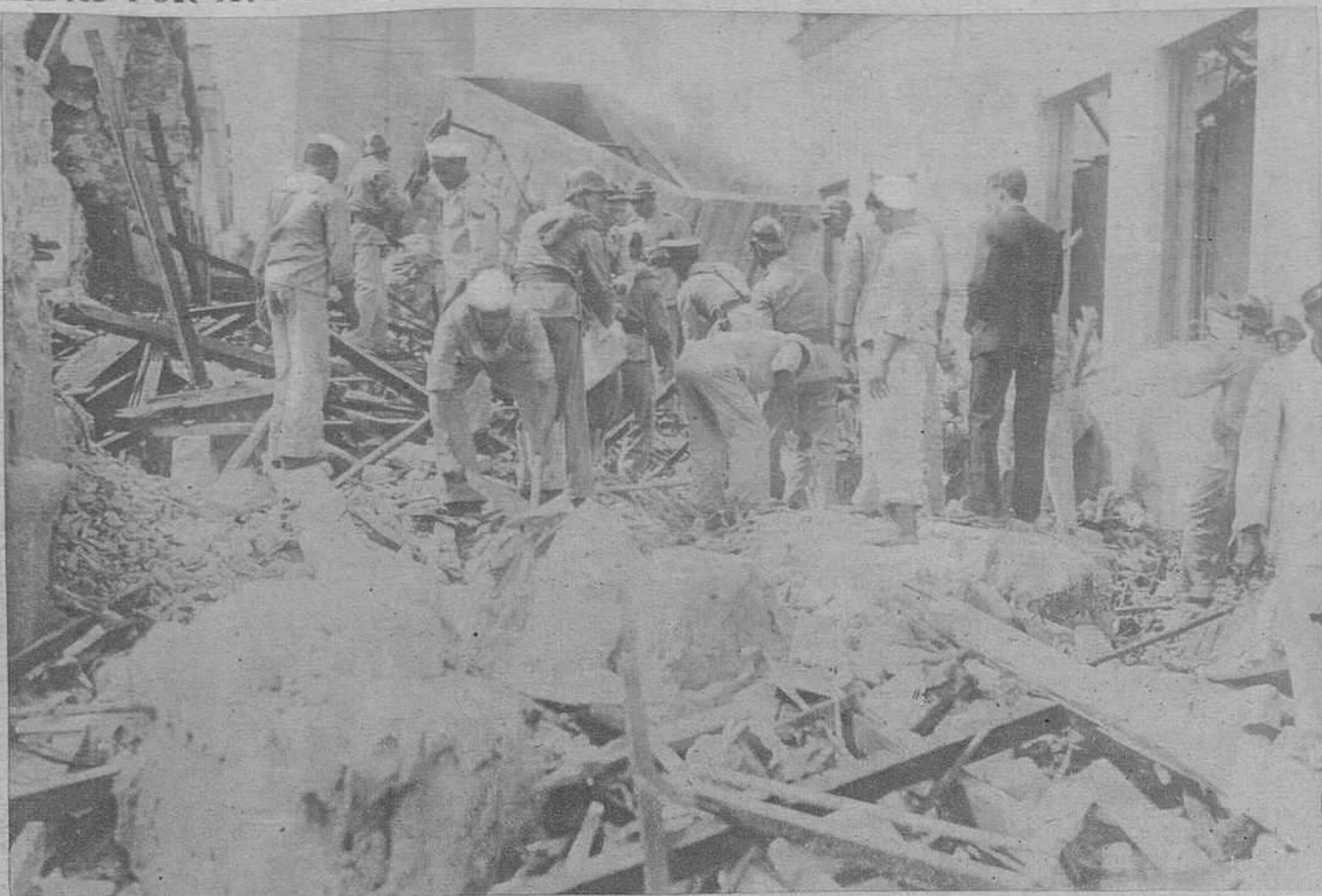
Marinos y bomberos retirando cadáveres de entre los escombros.
