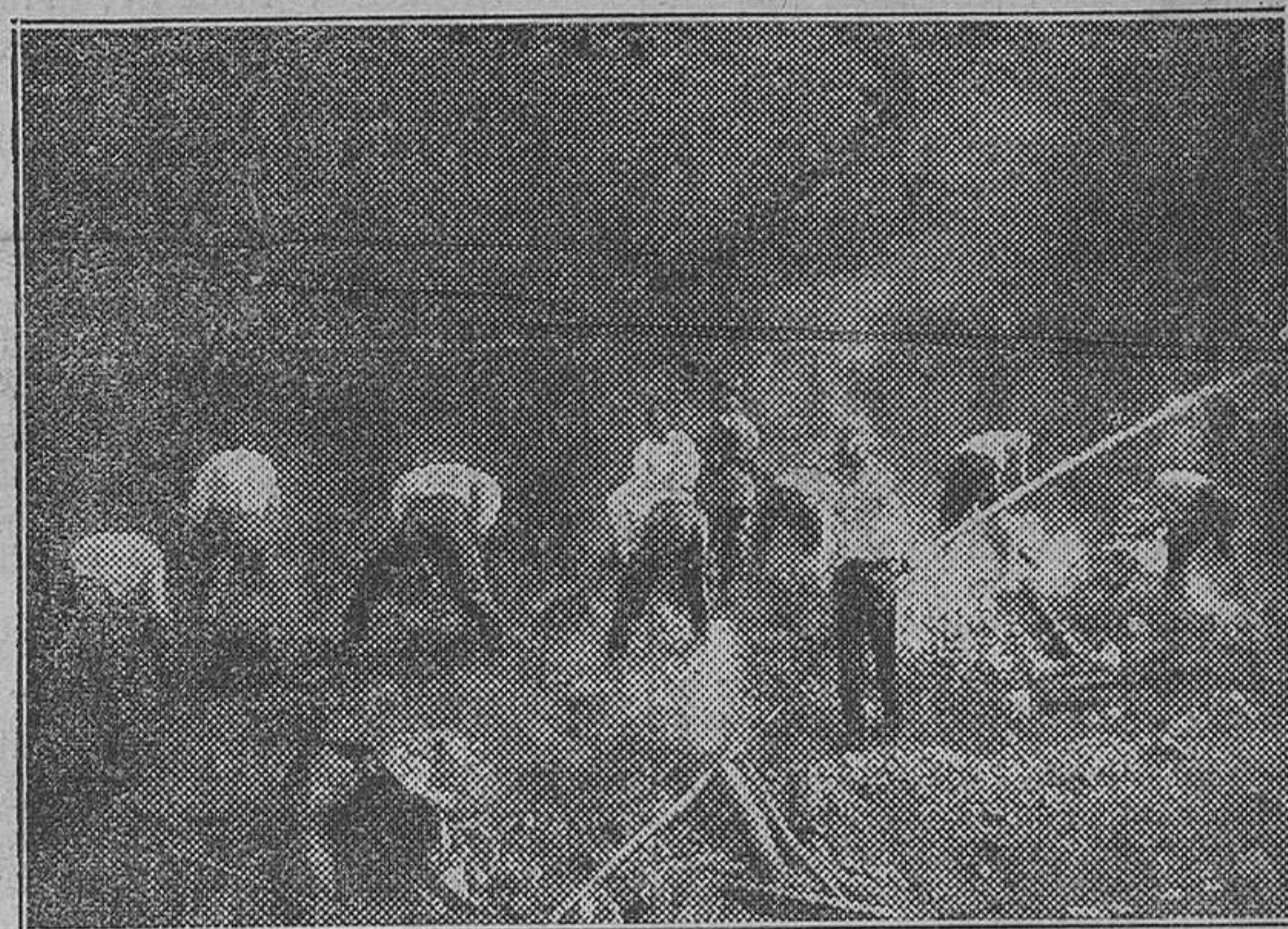
Funcionando las bombas en pleno incendio
