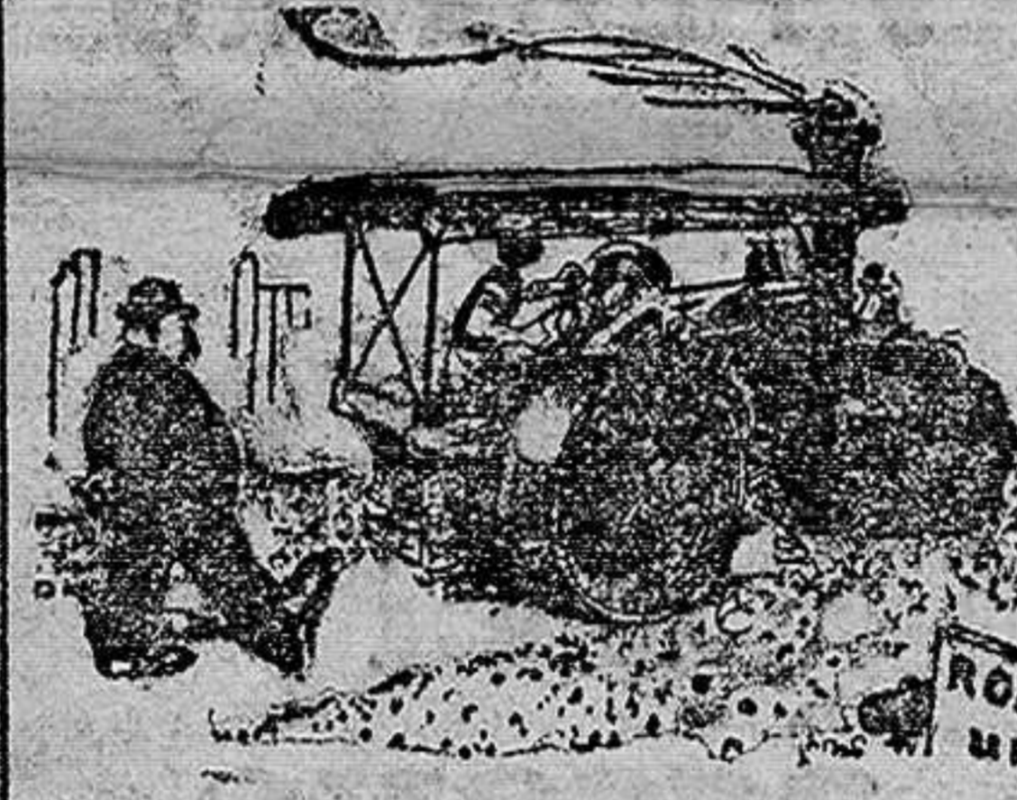
Acabando la obra fascista
