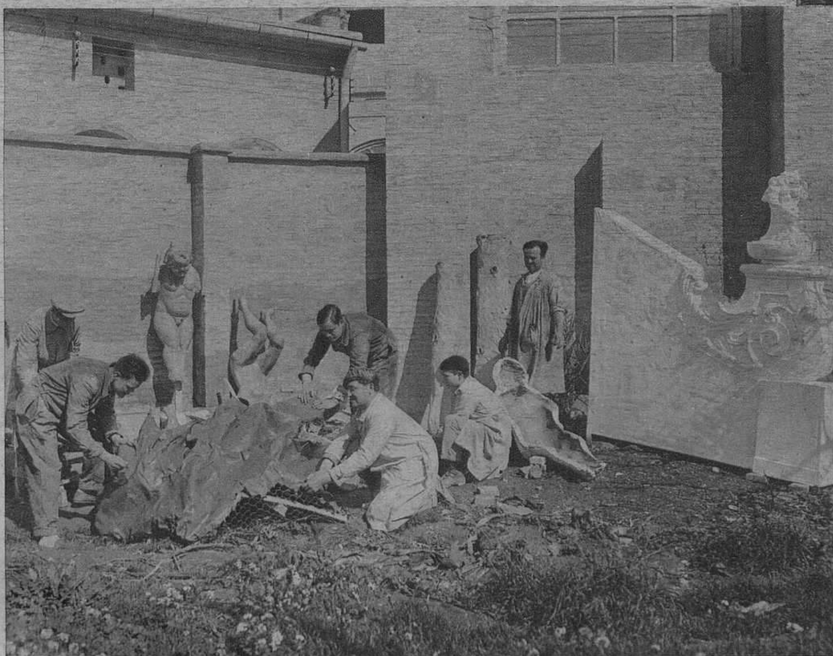
Cubriendo un armazón de alambres con cartón, surgen edificios suntuosos que solo puede concebir la imaginación del artista. (Foto Desfilis)
