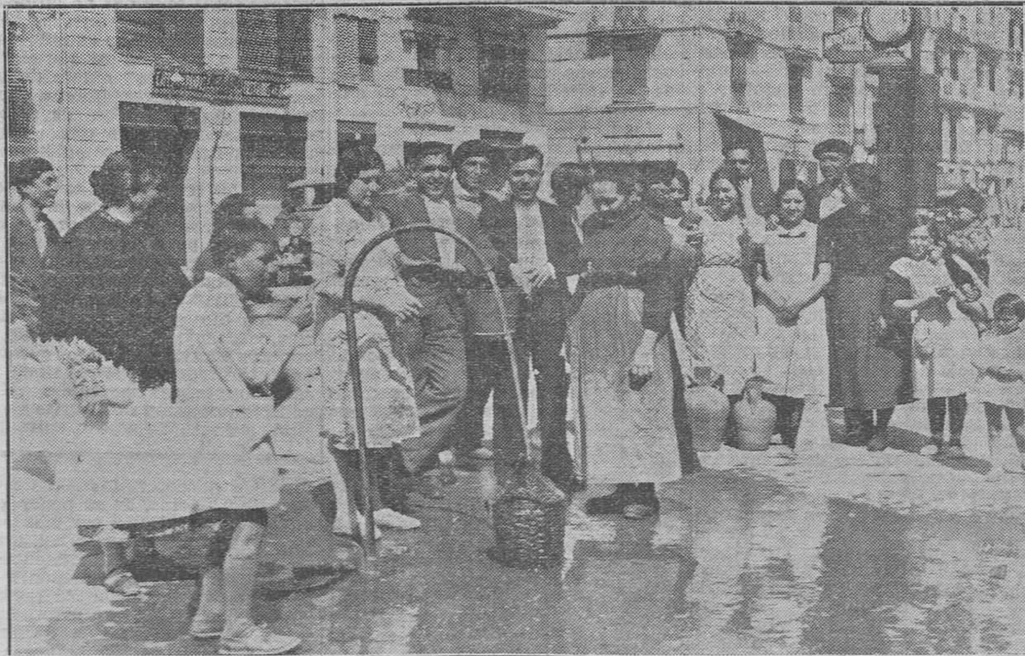
A causa de haber sido destruida una cañería del agua por explosión de una bomba, Valencia se quedó poco menos que desabastecida. He aquí una improvisada fuente en la calle de Cuarte
