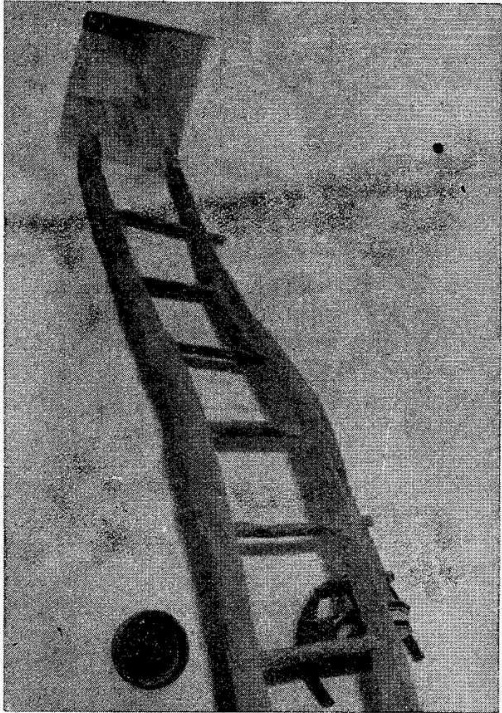
Escalera movable de la Torre de Binifadet
