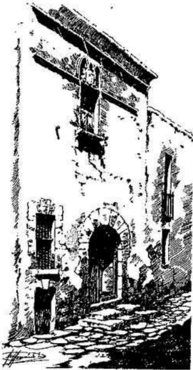
L'antiga casa de la Universitat de Maó enderrocada l'any 1886
