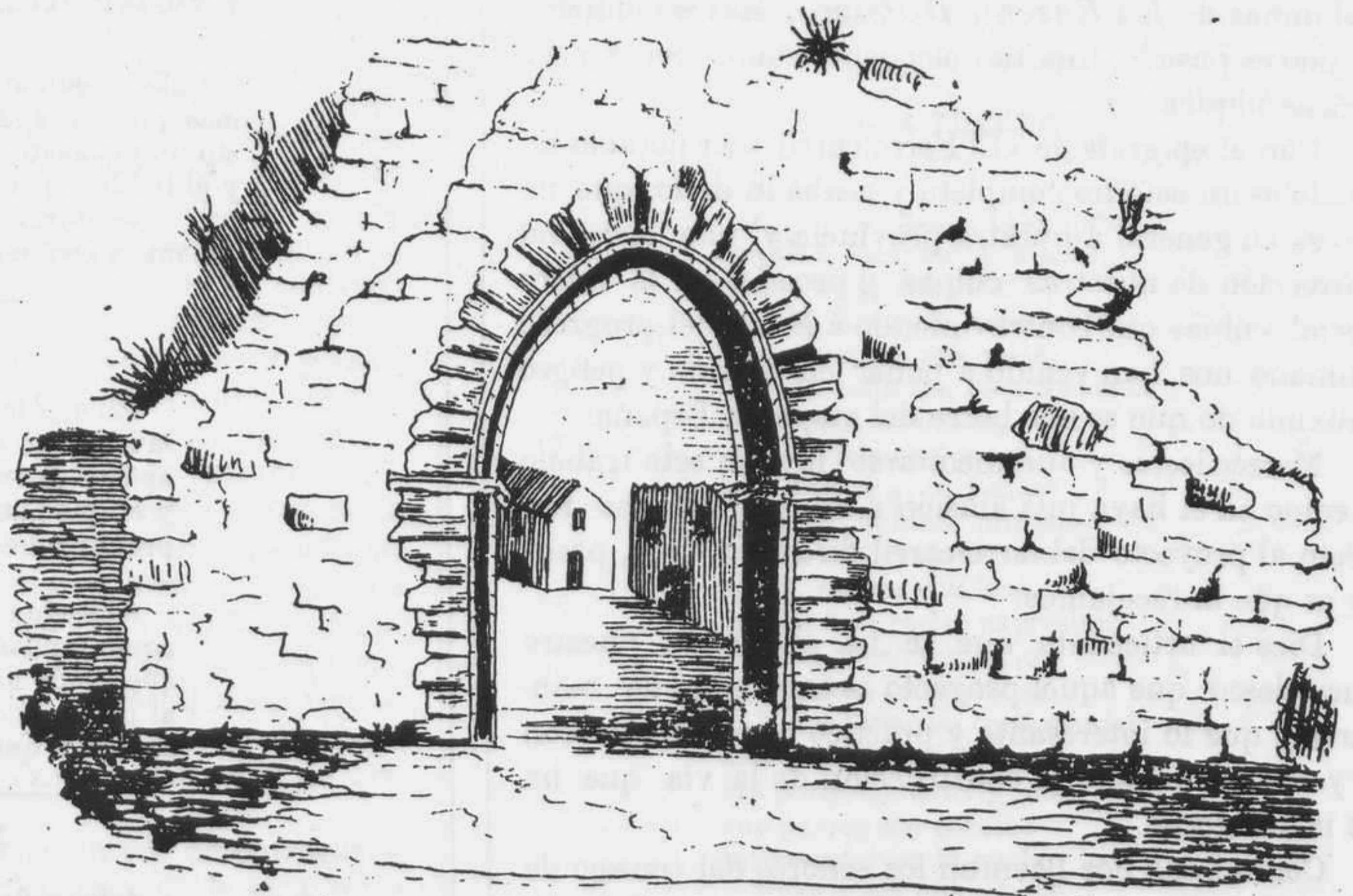
Antigua puerta de Benavente.
