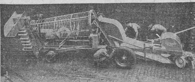
Máquina para recoger patatas, construida en una fábrica inglesa, que no precisa más que un hombre para su manejo y puede levantar 1,62 hectáreas de terreno diariamente.
