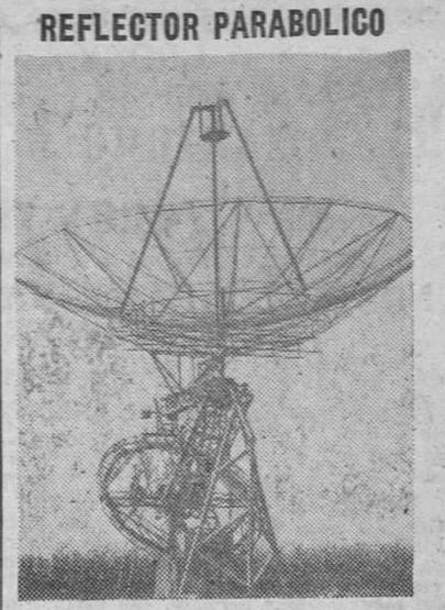
La última adquisición del Radio Observatorio de la Universidad del Estado de Ohio es este reflector parabólico de 40 pies, cuya orientación puede modificarse con objeto de que siga la dirección de los cuerpos celestes a través del firmamento. Está, además, coordinado con el radio telescopio helicoidal de 160 pies de largo, de la Universidad.
