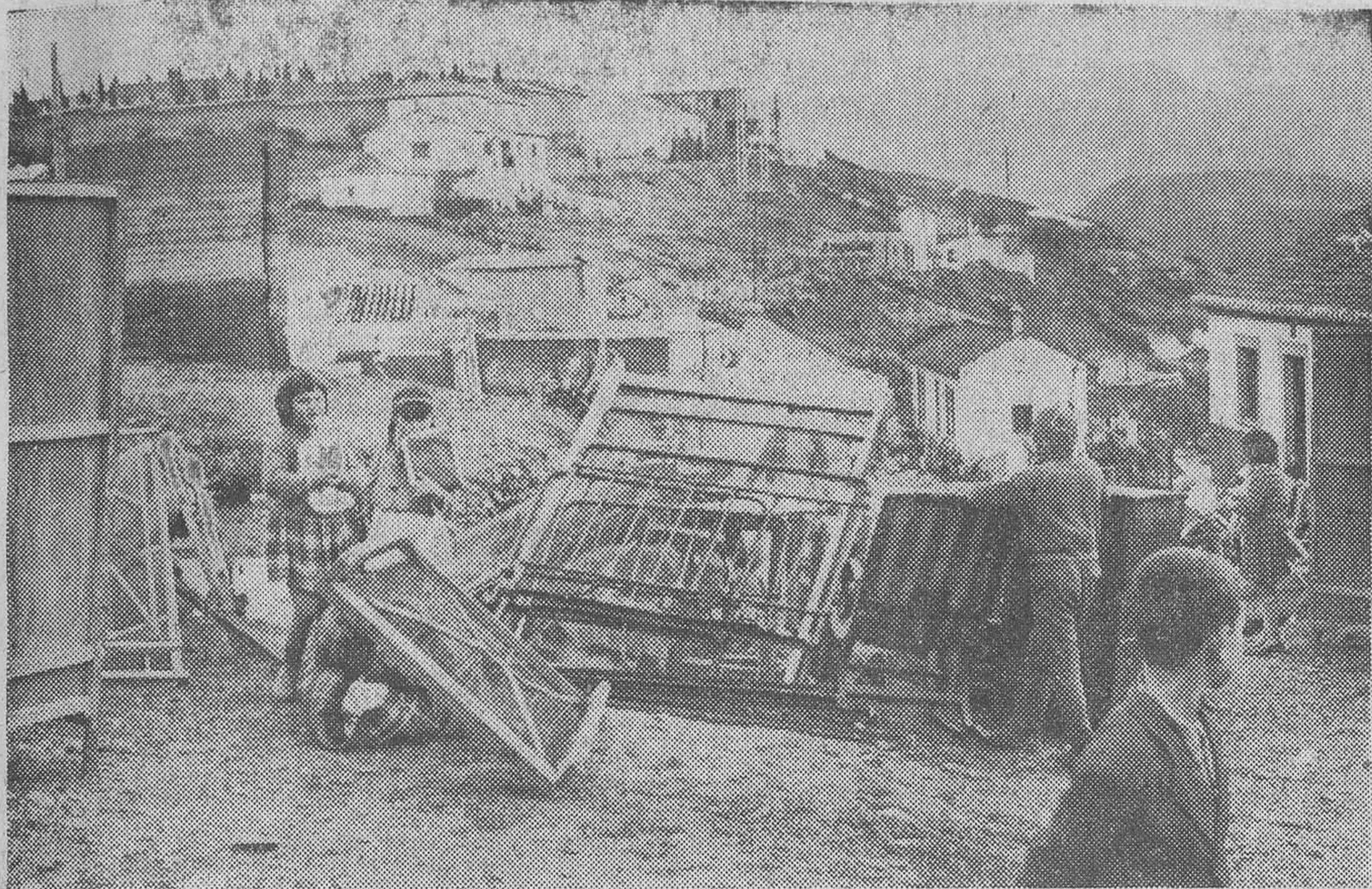
Ayer continuó la evacuación de las cuevas dañadas por el temporal y en peligro de derrumbamiento. Nuestra fotografía recoge un aspecto de los trabajos que con tal motivo se realizan estos días desalojando las que hasta ahora han sido humildes viviendas llamadas a desaparecer de la geografía granadina. (Foto T. Molina)
