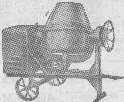
Hormigoneras «JAU-LICE», provistas de rodamientos de rodillos cónicos, con fondo y puente de acero, con corona recambiable, en 160 y 300 litros.
