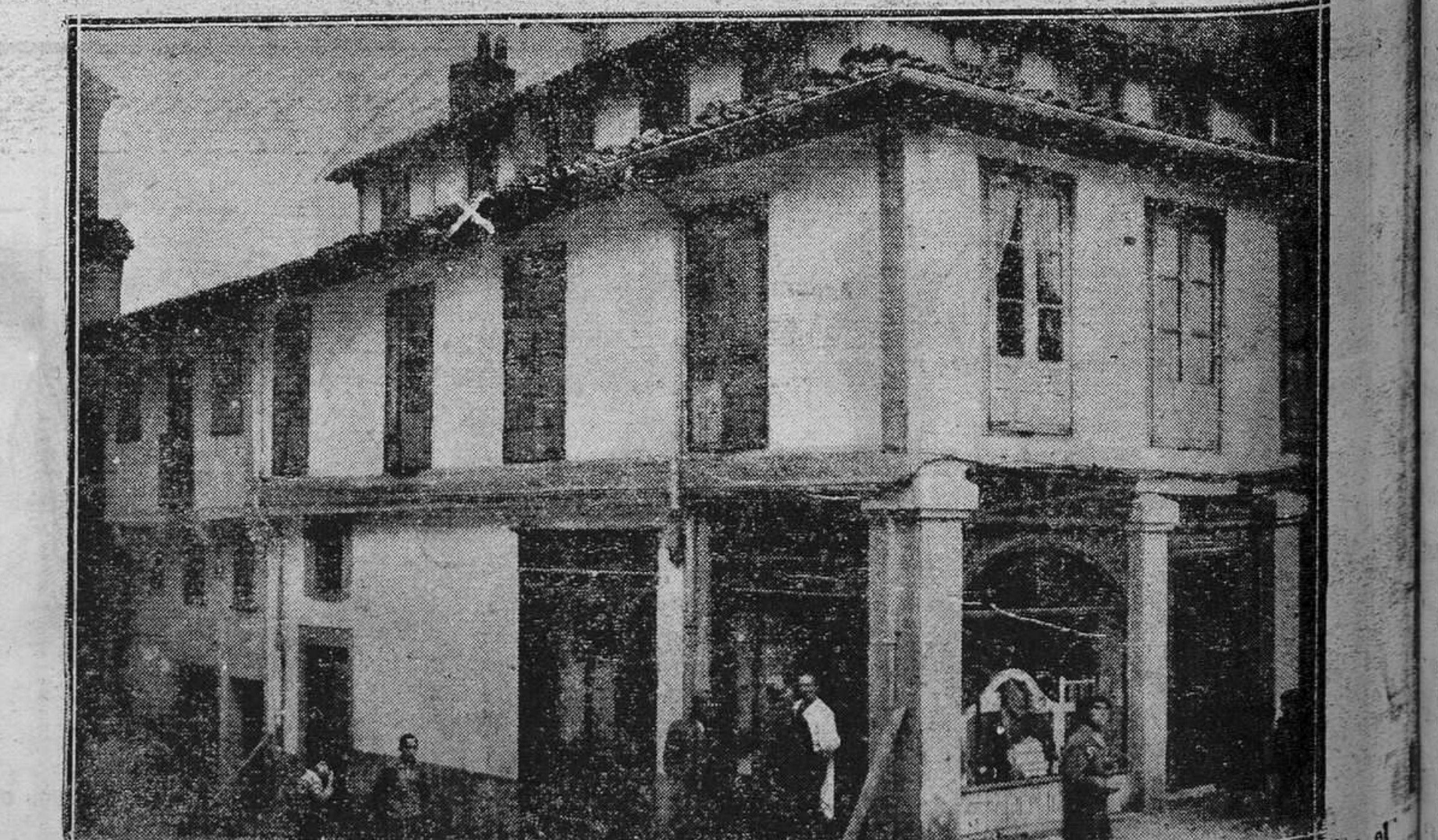
OVIEDO.—Casa de la plaza del Ayuntamiento desde cuyo tejadillo (X) cayó ayer y se mató el obrero Joaquín Sánchez García. (Foto Mena).
