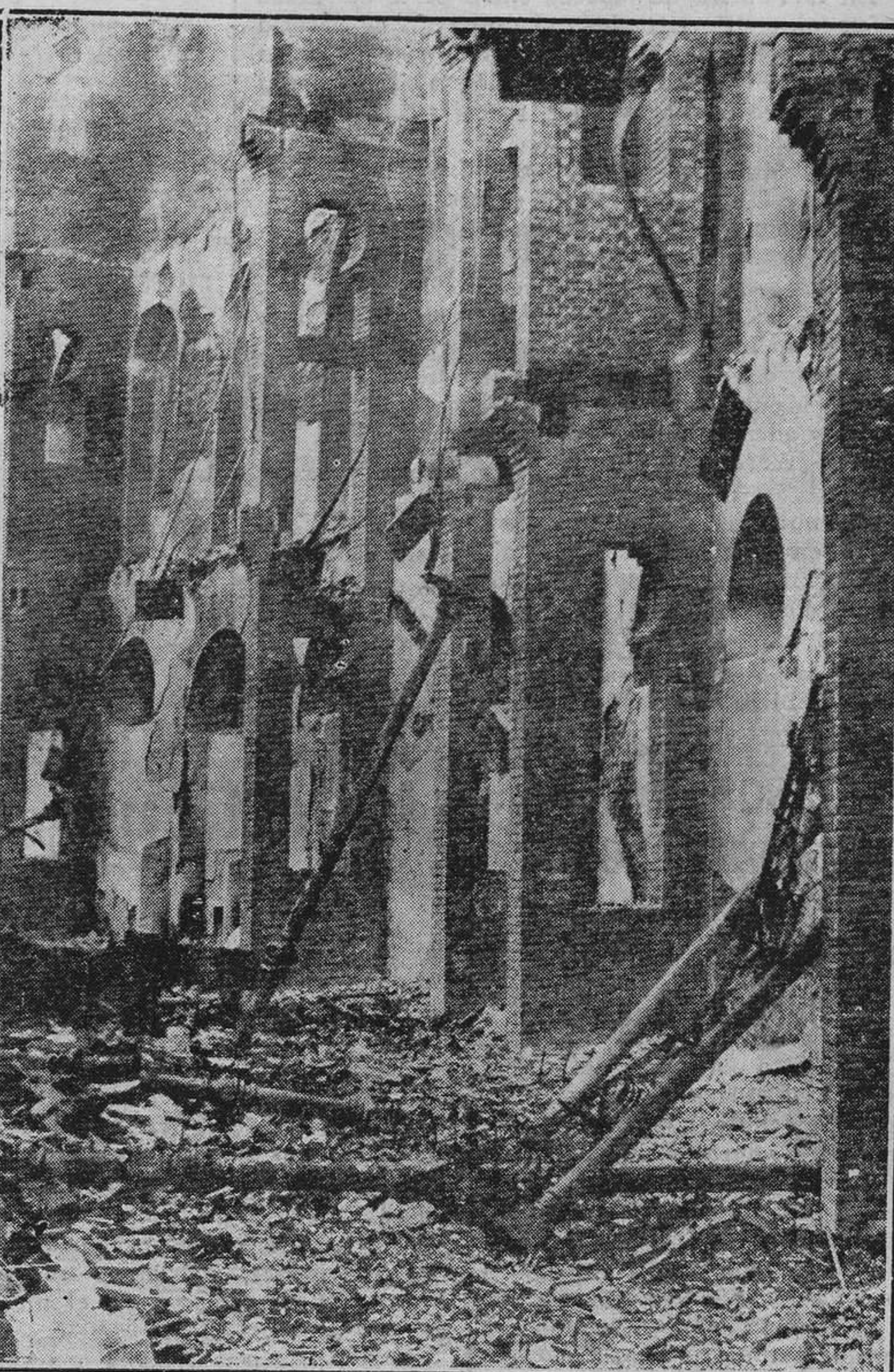
OVIEDO.—Estado en que quedar on los pasillos después del incendio de ayer en la Plaza de Buena vista. Foto MENA
