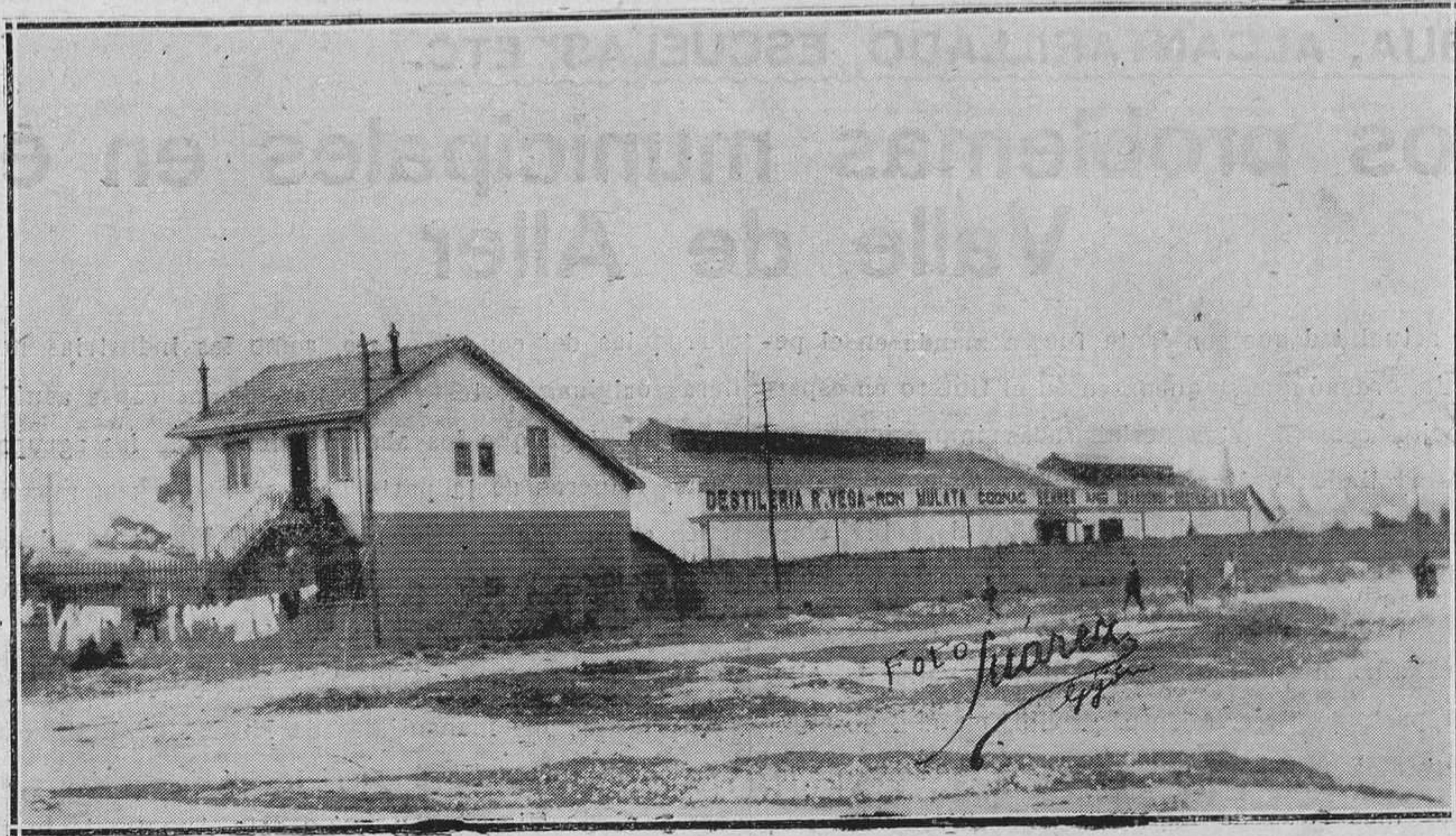
Vista de conjunto de las importantes destilerías de R. Vega, de Gijón, fabricante de los insuperables productos Ron Mulata, Cognac Serres y Anís Covadonga.
