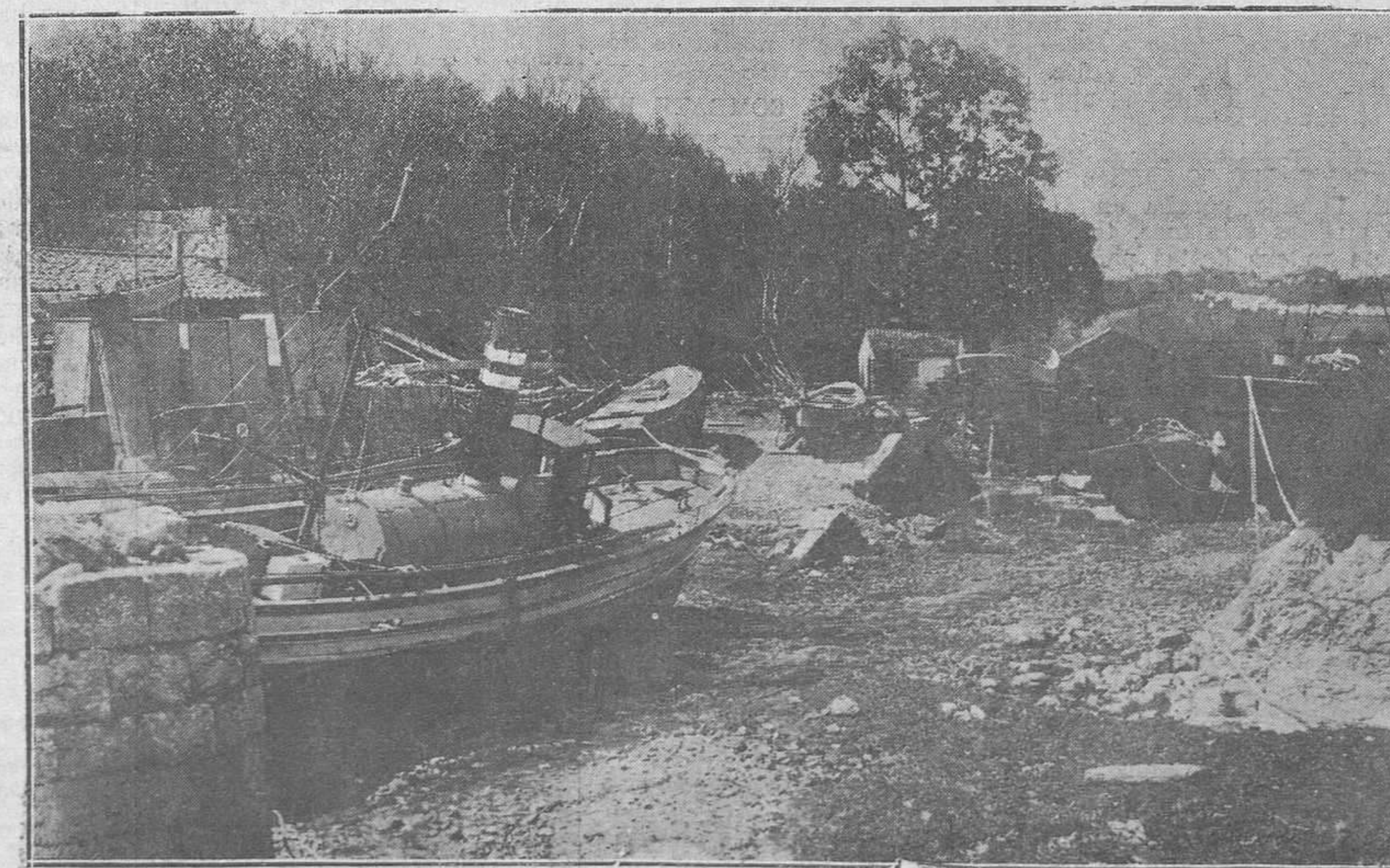
LUANCO.-Vista general del dique.
