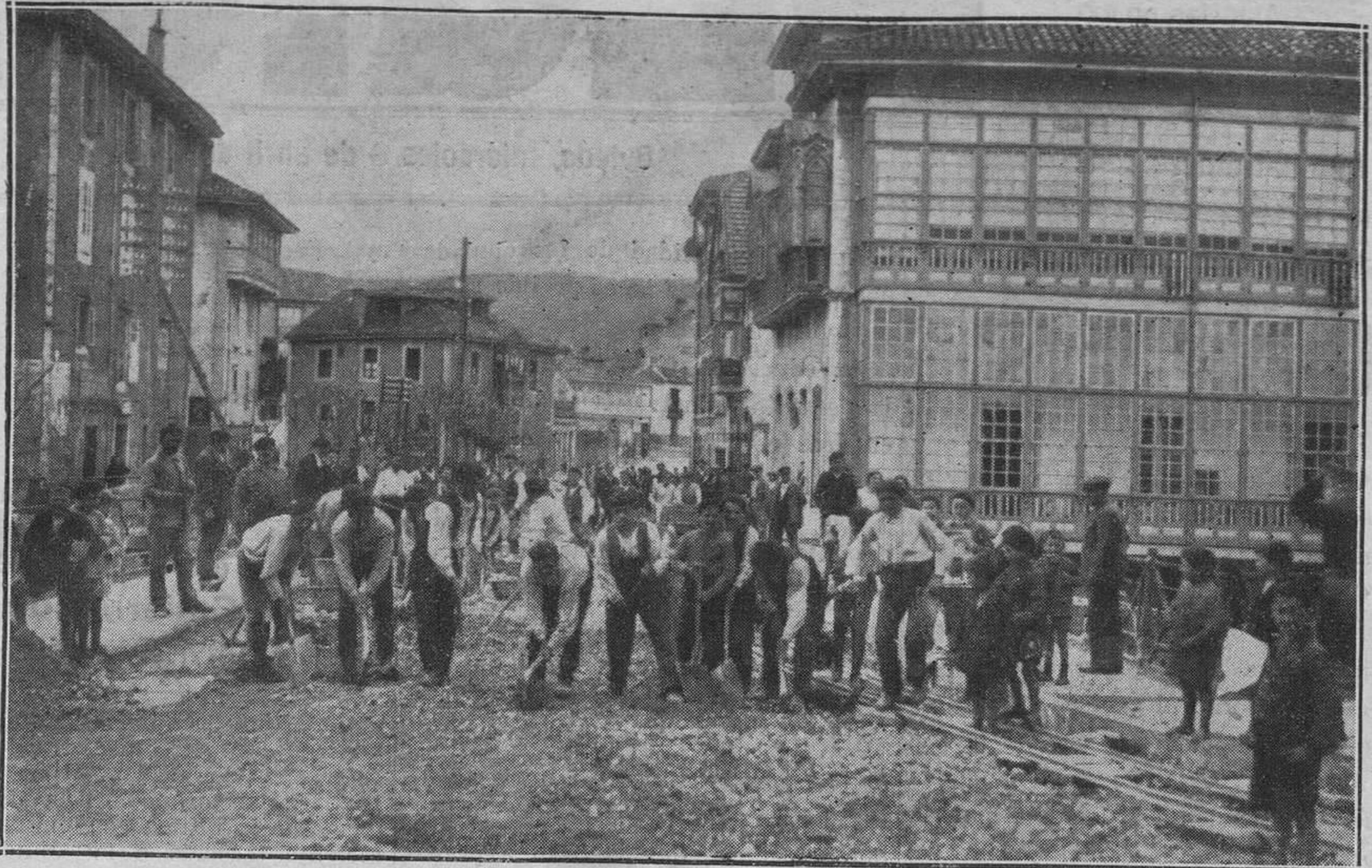
LLANES. —Con una actividad aquí desconocida hasta ahora, y con las mayores garantías de perfección técnica, se efectúan las obras de asfaltado, llegando ya a la plaza de Las Barqueras. El contratista se propone terminar en tres meses una obra para la cual se le concedieron tres años. La extensión de la obra es de un kilómetro, y en un mes han sido asfaltados 400 metros. (Foto M. T.)
