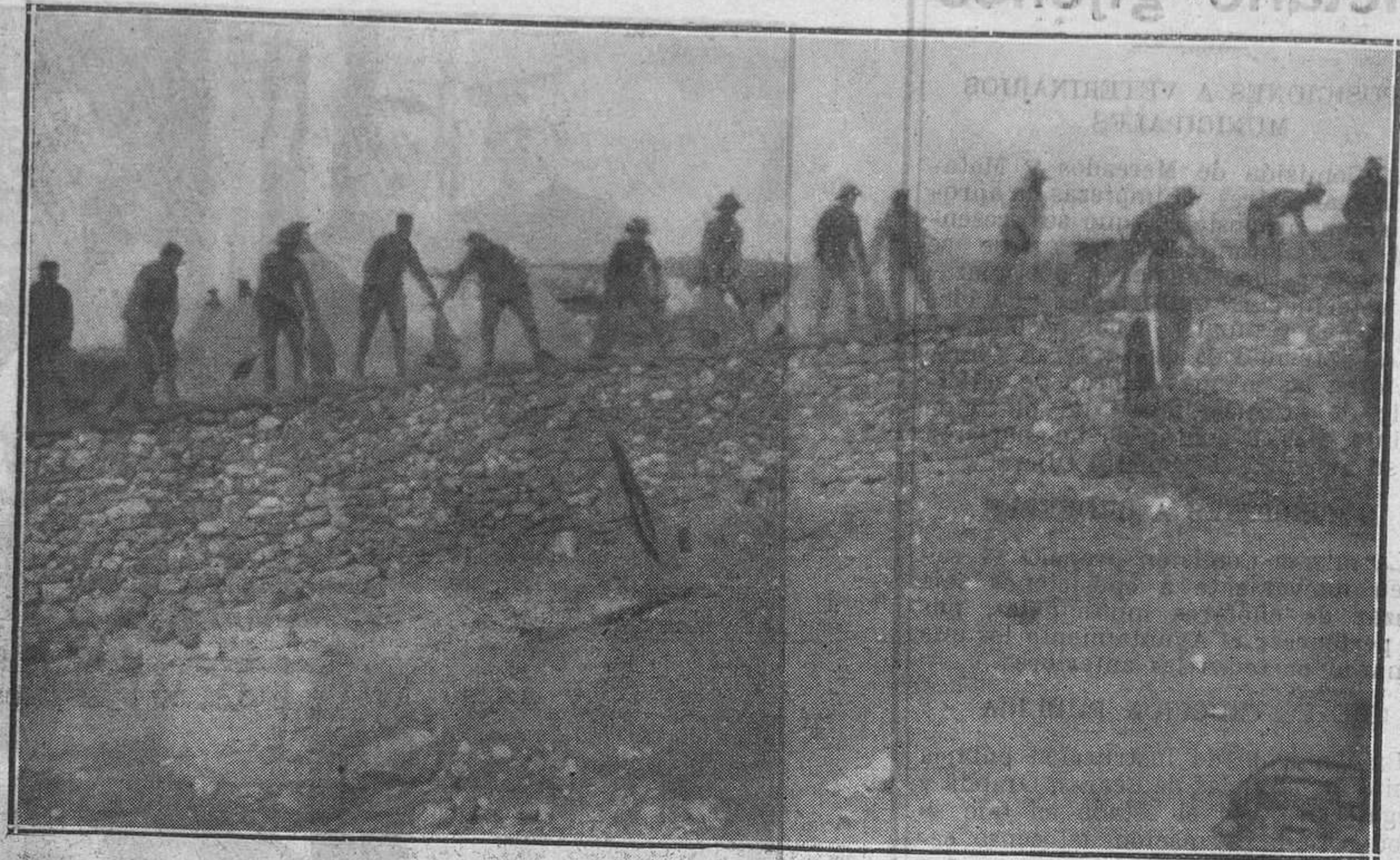
ACCIÓN DE ESPAÑA EN MARRUECOS.—Construcción del parapeto en Buhafora, punto de aprovisionamiento del sector Tizzi Azza. (Foto Ellas)
