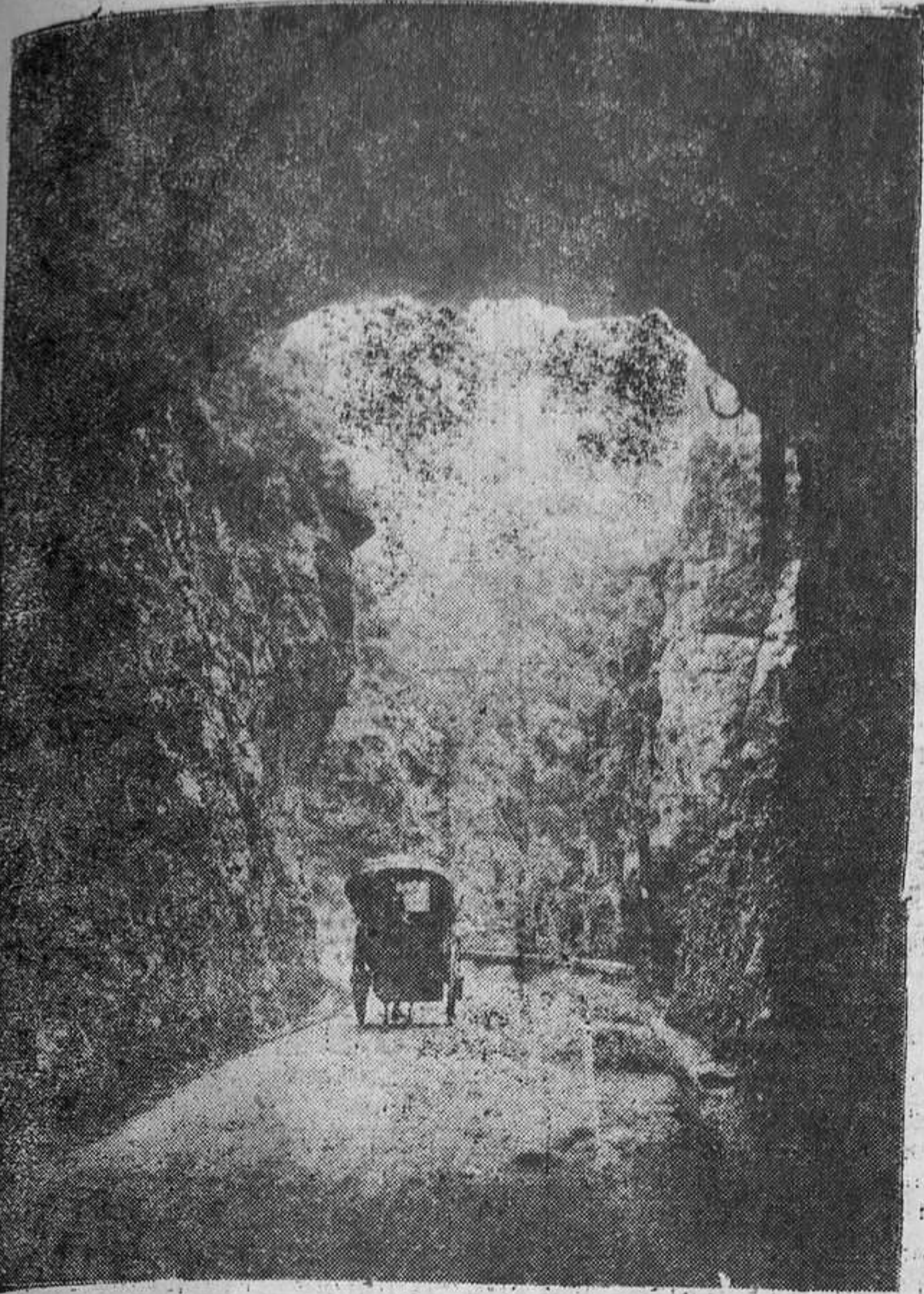
ASTURIAS.—Carretera de Somicdo. (F. Collada).
