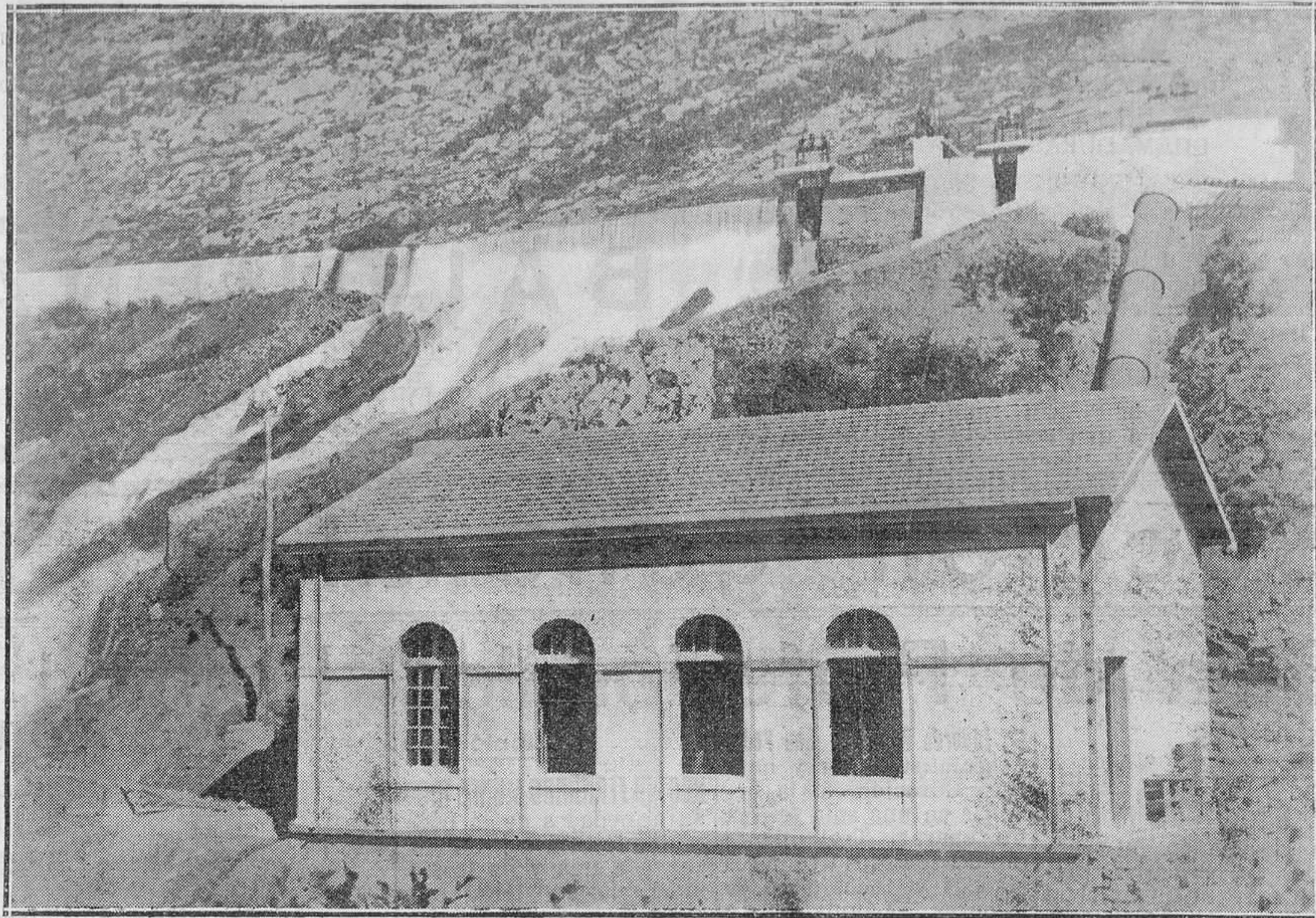
SOBRESCOPIO.--Vista general de la Electra de Riaseco.
