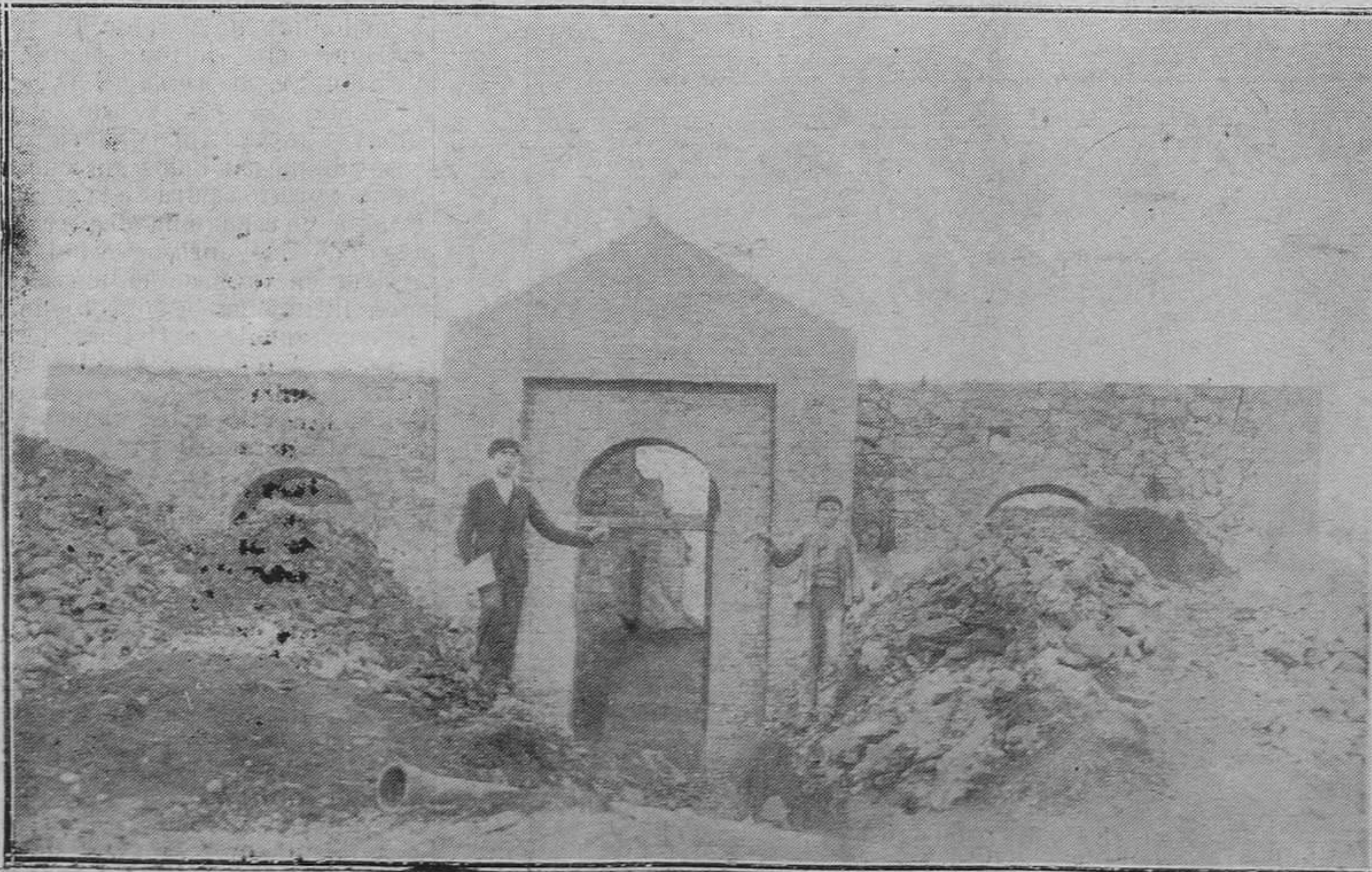
LLANERA. El depósito en construcción, que surtirá de aguas a los pueblos de Posada y Lugo y al nuevo mercado. La inauguración se verificará mañana (Foto Barriuso).
