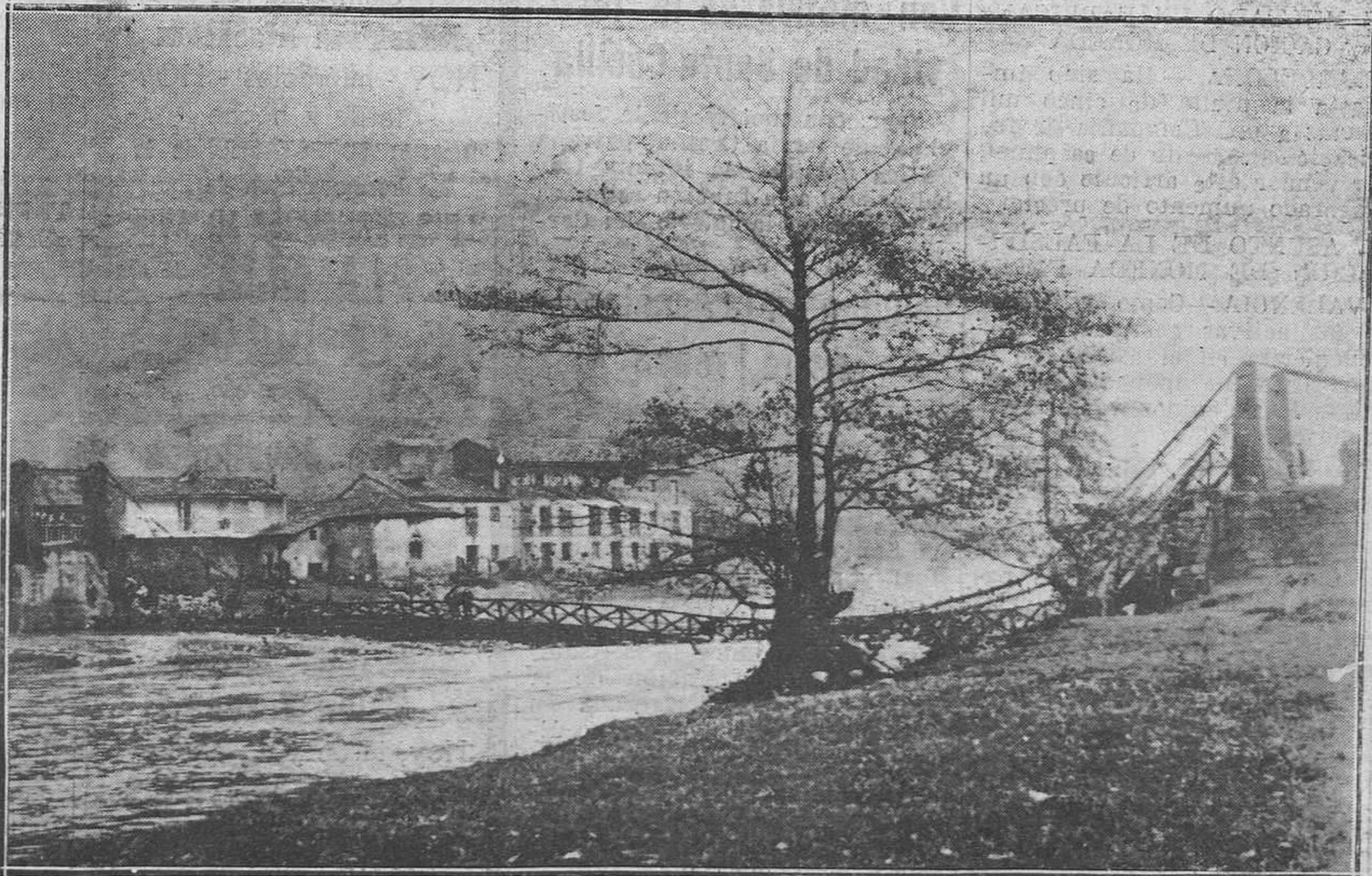
Ciaño Santa Ana.—Otro aspecto del puente de La Oscura después de su hundimiento.
