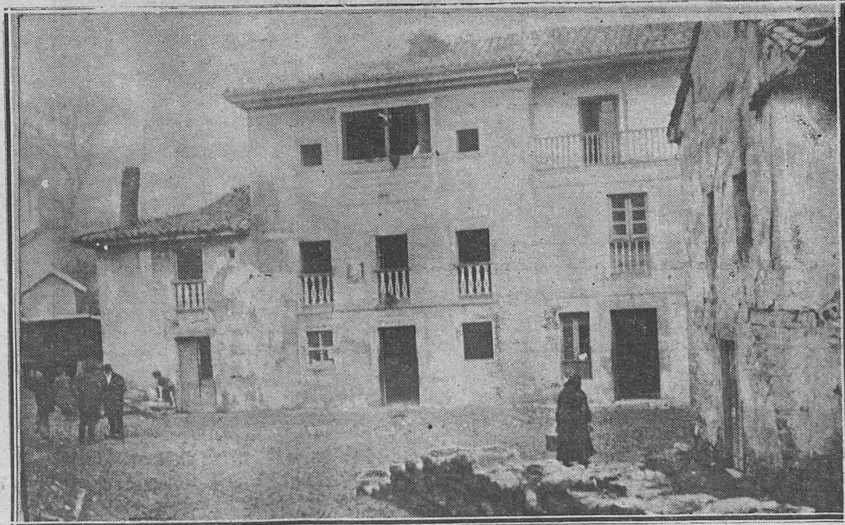
La Oscura.-La casa de don José García, convertida, en la tarde del domingo, en Clínica de urgencia y donde fueron curados la mayoría de los heridos en el hundimiento del puente. (Foto Mena)
